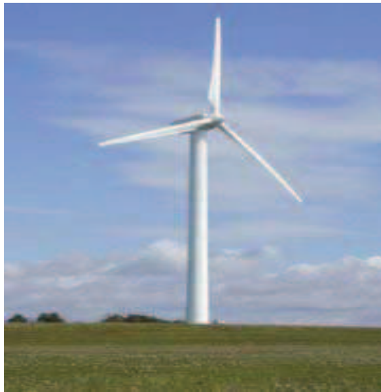
Fig. I. 4 : Aérogénérateur à axe horizontal.
