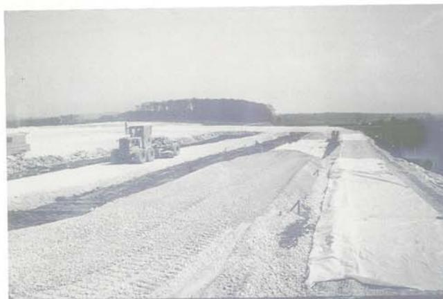
Fig F100 : Chaussée provisoire expérimentale (Ponts et
