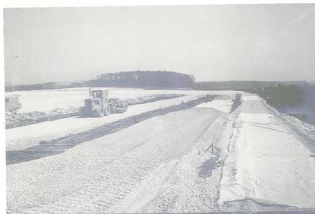
Fig F100 : Chaussée provisoire expérimentale (Ponts et Chaussées Nancy - Delmas)
