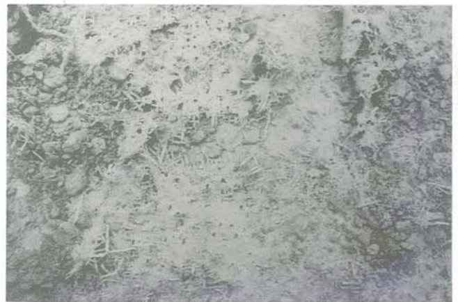
Fig F11 : Destruction du géotextile par abrasion
