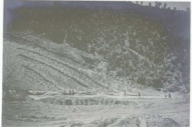
Fig. D13 : Barrage en terre de Valcros Tranchées drainantes avec BD 300
