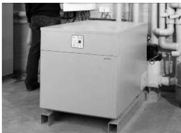
Figure 2.15 : Installation de la machine frigorifique à absorption Rotartica à l'INES (source : F. Boudéhenn / CEA)
