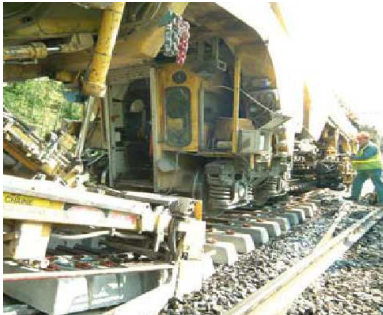
FIGURE 4.4: Exemple d'opération de relevage.
