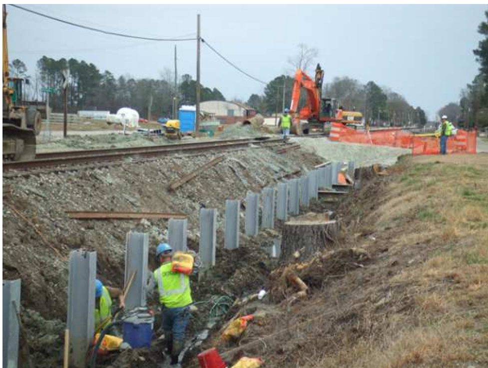
FIGURE 4.14: Exemple d'opération d'exécution de fossés de drainage.
