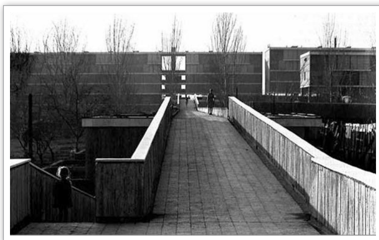
Figura N° 12: Calle elevada, Villa Portales
