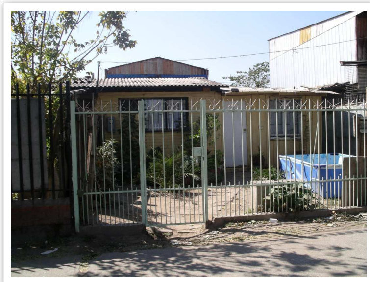
Figura N° 48: Vivienda, El Castillo
