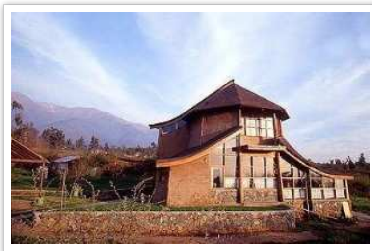
Figura N° 68_ Casa de adobe, Comunidad Ecológica de Peñalolén
