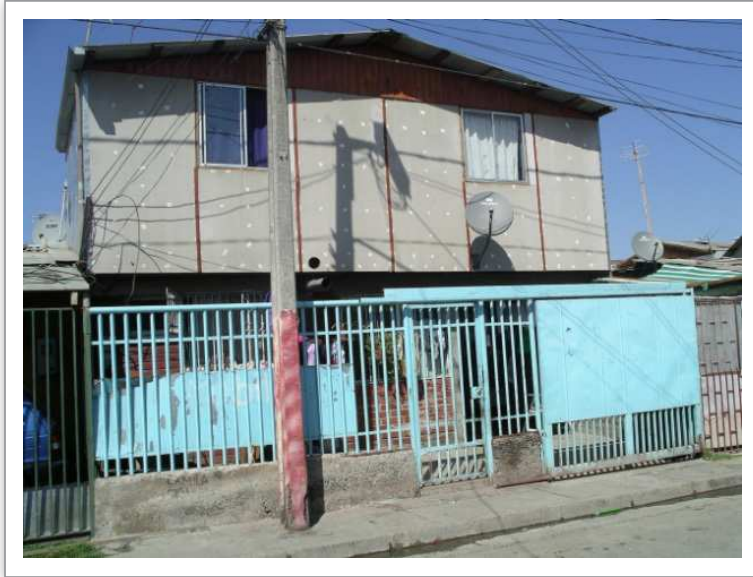
Figuras N° 40, 41 y 42: Viviendas de bajos ingresos, La Pintana
