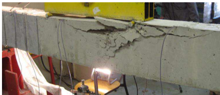
Figure 235 : Poutre « R30-B-FI-P-TRC(10) » après rupture
