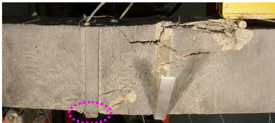
Figure 219 : Poutre « R30-B-U-Is-TRC(5) » après rupture
