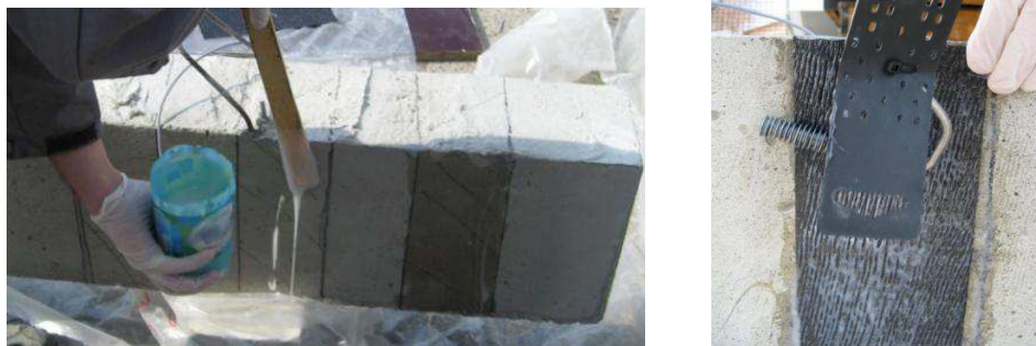
Figure 201 : Mise en œuvre du composite de réparation CFRP sur la poutre
