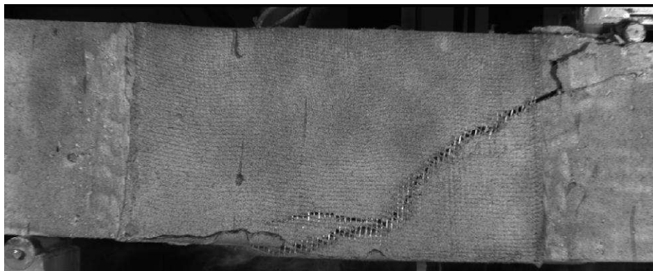
Figure 224 : Poutre « R40-C-U-Is-TRC(2) » après rupture
