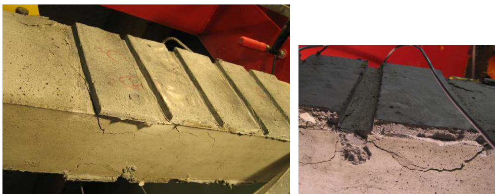
Figure 233 : Poutre « R30-B-FI-P-TRC(10) » après rupture (face inférieure)
