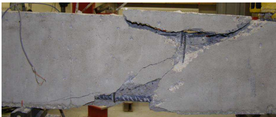
Figure 227 : Seconde poutre « R30 » après rupture (travée sous dimensionnée à l'effort tranchant)
