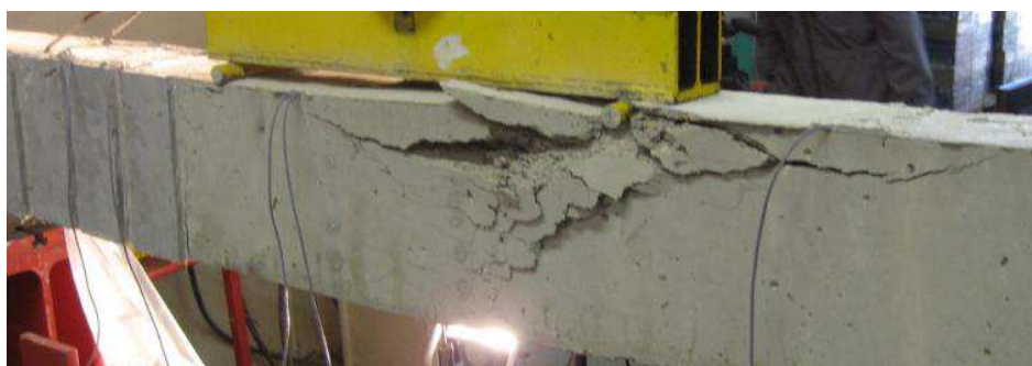
Figure 217 : Poutre « R30-B-FI-P-TRC(10) » après rupture
