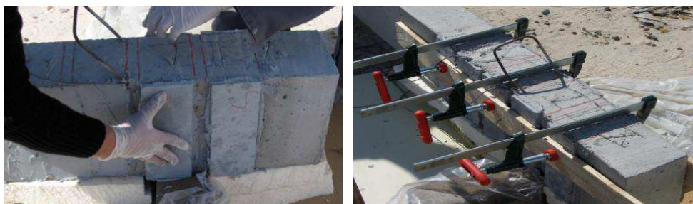
Figure 202 : Mise en œuvre du TRC de réparation par collage de plats préfabriqués
