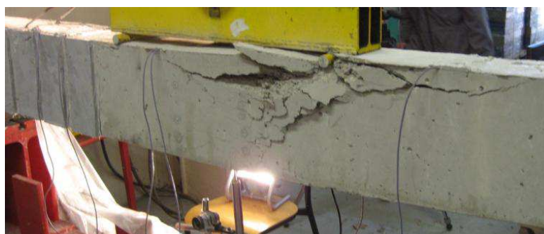
Figure 235 : Poutre « R30-B-FI-P-TRC(10) » après rupture
