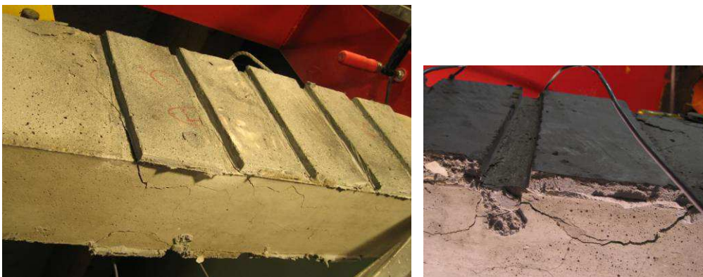
Figure 265 : Illustration de la poutre « R30-B-FI-P-TRC(10) » après rupture
