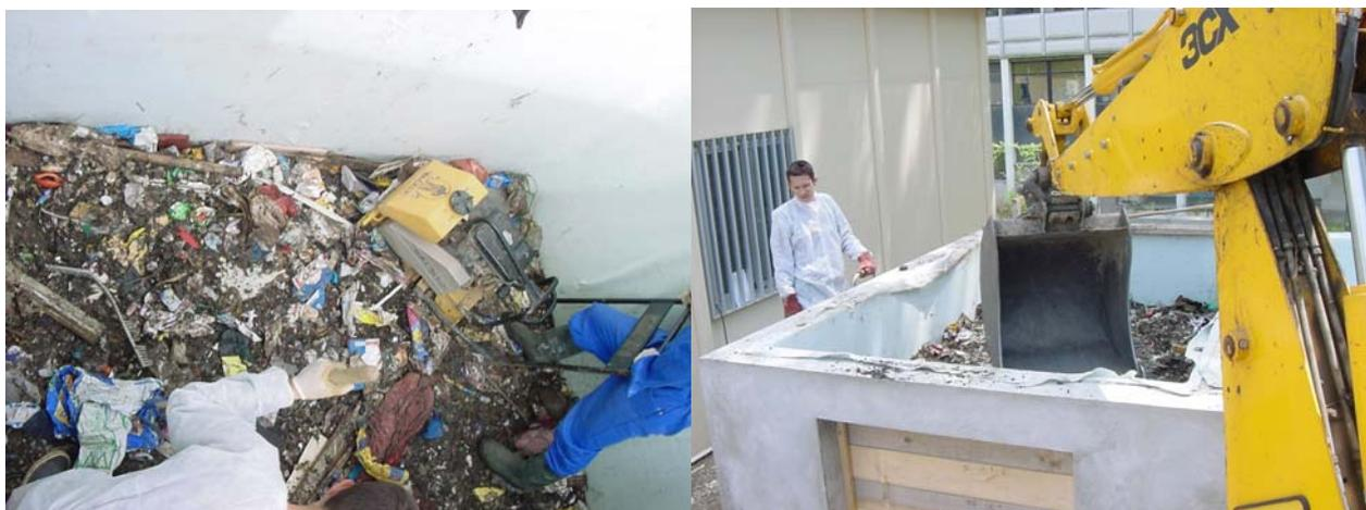
**Figure 4.32** Compactage des déchets à la vibreuse à main et au godet (Araujo Morais, 2003)
