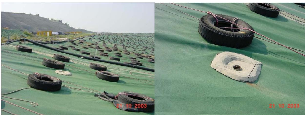
**Figure 10.14** (a) Vue du talus de la phase 2 couverte provisoirement (b) Gros plan sur la borne topographique n° 37 (Site de Hong Kong)
