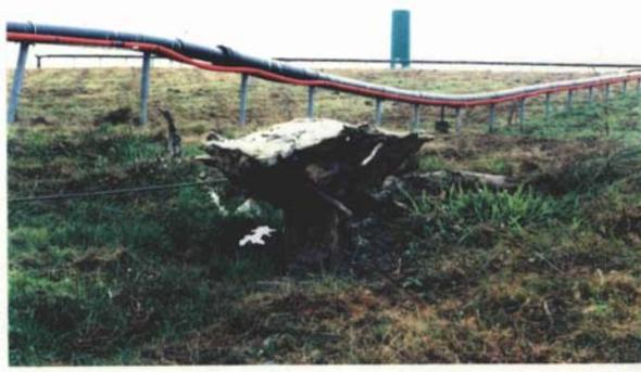
**Figure 9.1** Perturbations d'un réseau aérien de drainage des biogaz (Source : Antea)
