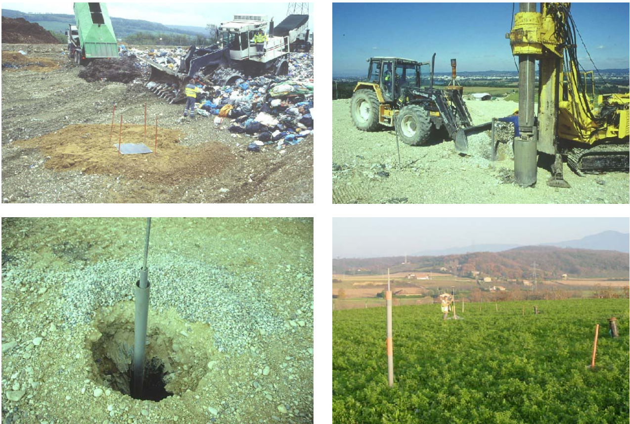
Figure 5.40 Illustration de l'installation de plaques enterrées et tiges flottantes sur le CSD de Chatuzange (a) Mise en place de la plaque sur lit de sable (b) Forage, mise en place du tubage grand diamètre et du gravier annulaire (c) Gros plan sur la cavité après installation des deux tubages PVC et de la tige flottante (d) Vue du dispositif 18 mois plus tard (après enherbement)
