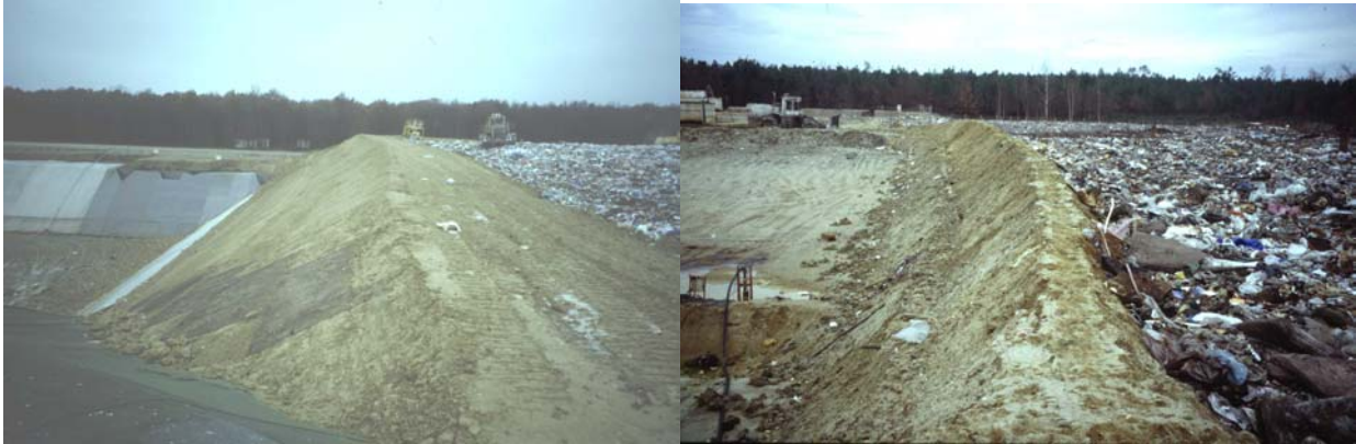
Figure 9.14 Zones singulières au voisinage des digues inter-alvéole (a) CSD de Montech (b) CSD de Lapouyade
