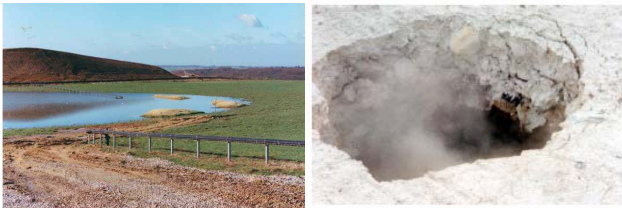
Figure 9.2 (a) Illustration du tassement différentiel sur un CSD en Belgique (b) Rupture d'une couverture crayeuse après combustion interne (Riviere et al., 2003)
