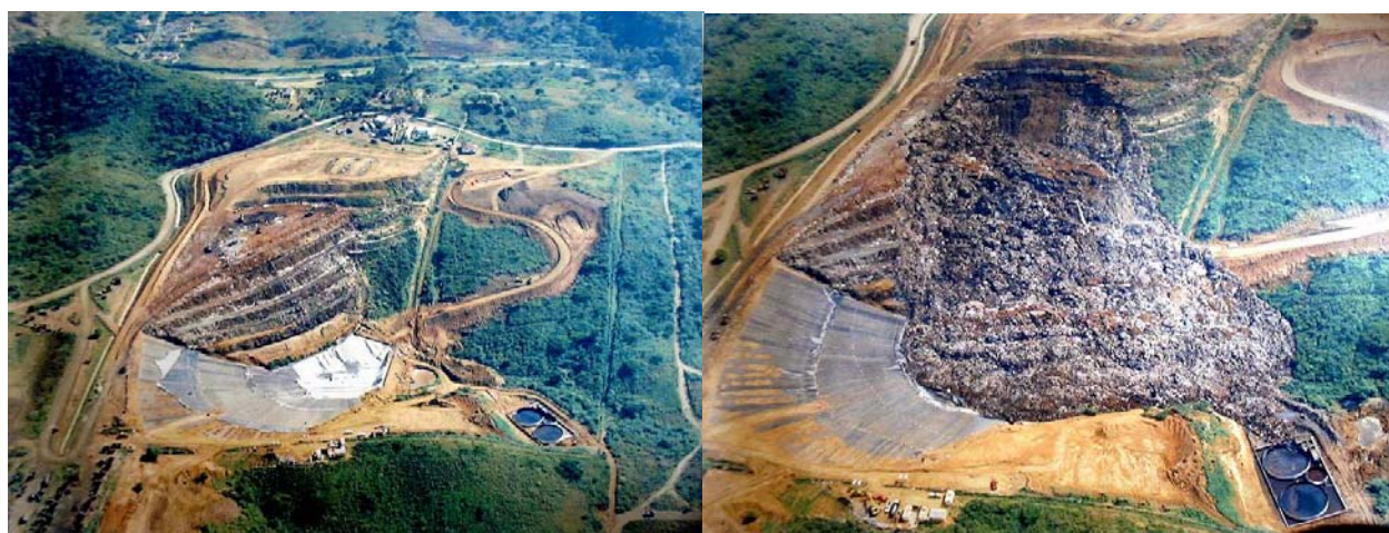
Figure 10.1 Photo aérienne du talus de Bulbul Drive (Afrique du Sud) avant et après rupture (Brink et al., 1999)
