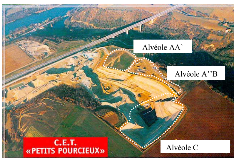
Figure 5.14 Vue aérienne du CSD de Chatuzange
