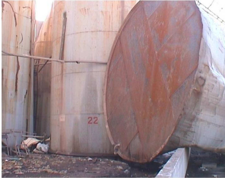
FIGURE 2.1 – Renversement d'un réservoir vide (AZF 2001).
