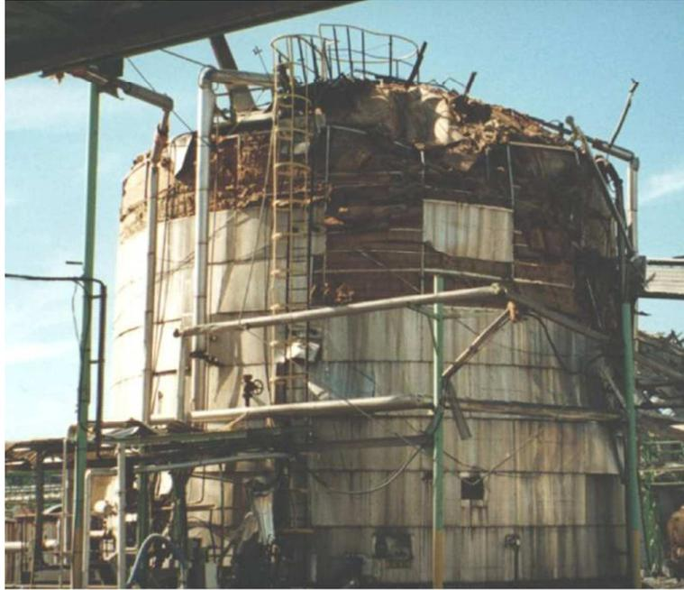
FIGURE 2.4 – Toit de réservoir enfoncé.
