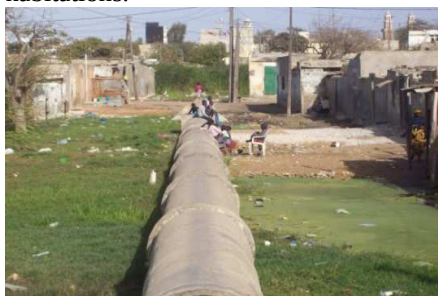
Photo 36 prise en 2009 Une vieille conduite d'eau de la Société des Eaux (SDE) qui surplombe la terre et qui était il y a, plusieurs années, en profondeur. Cette conduite, en période d'inondation, constitue le seul moyen de communication pour ces populations riveraines. On aperçoit des enfants
