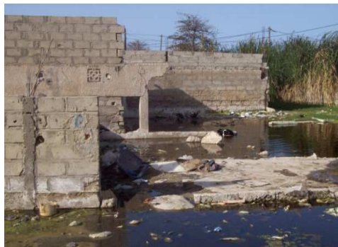
Photos 42-43 prises en 2009: Des murs soit en construction soit abandon. Présence de roseaux et de l'affleurement de la nappe phréatique dans ces espaces sensibles. Le non-respect et la non observation des normes en matière de construction a eu comme conséquences les effondrements des bâtiments anciens et même des bâtiments en construction.
