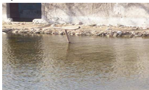
Photo 37 Une maison inondée même en période sèche au mois de Février.
