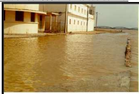
Photo 56: Inondation de 1999 : Pointe sud de l'île.
