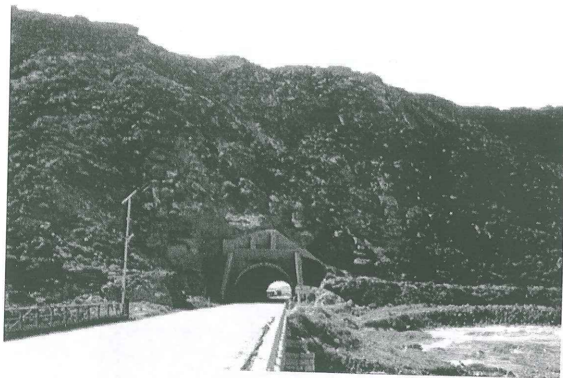
Figure III-88 Tunnel de Sarzeh situé à quelques centaines mètres de l'affleurement de Hormuz à Khurgu. Il ne présente pas d'indices de mouvement du diapir de Khurgu. Localisation du tunnel sur la Figure III-85.
