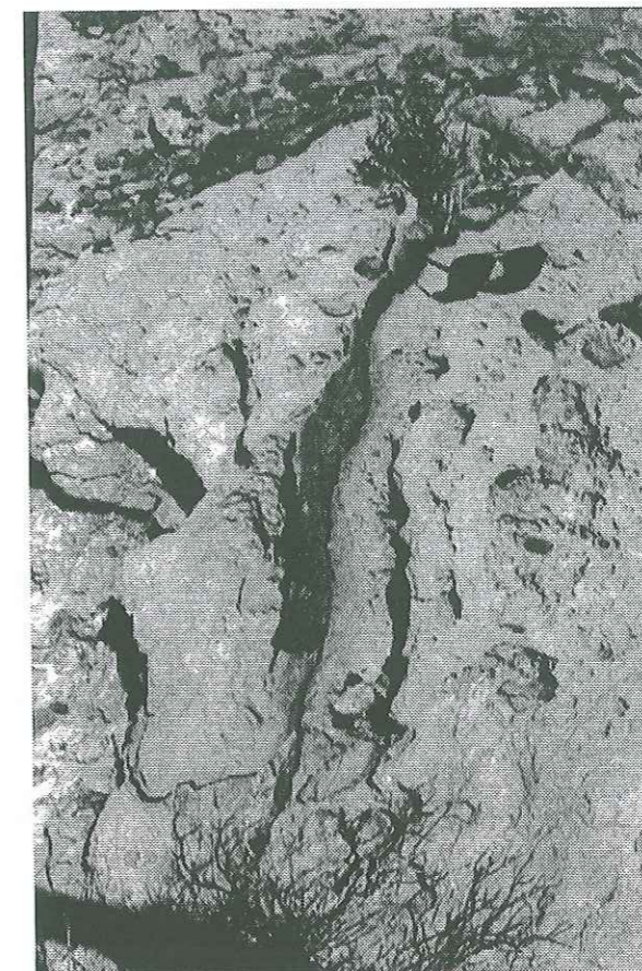
Figure III-84 Série de Hormuz injectée dans les fissures des calcaires.
