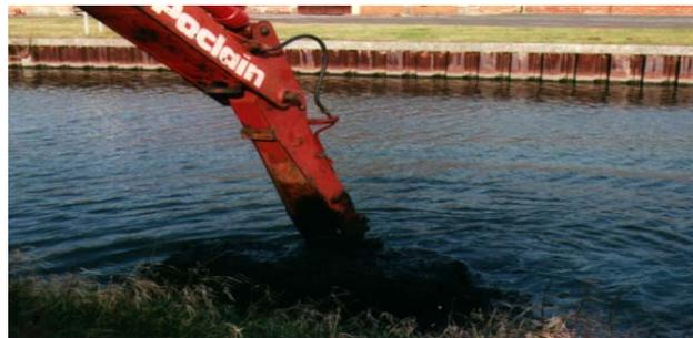
**Photos 1 :** Prélèvement du sédiment dans le canal de la Scarpe à l'aide d'une pelleuse.
