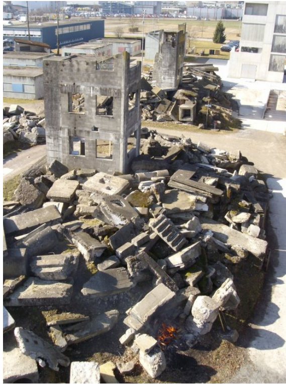
Figure A.10: La zone d'entraînement des pompiers à Zurich: le site choisi pour la démonstration finale du projet sFly.
