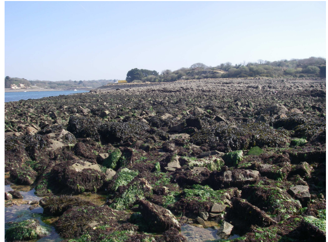
b) Vue de la quatrième strate constituée de blocs fixés (Photo M. Bernard)
