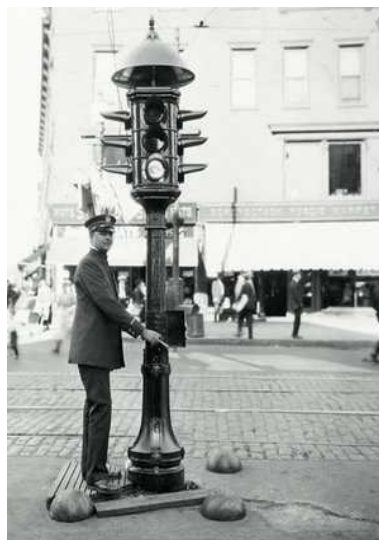
FIGURE 1.1 – Le premier feu de circulation électrique à Cleveland
