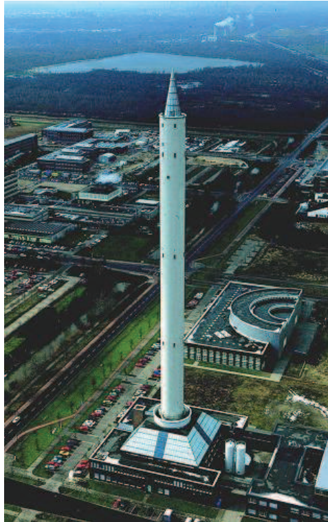
FIGURE 1.1 – Tour à chute libre de Brême (Allemagne).
