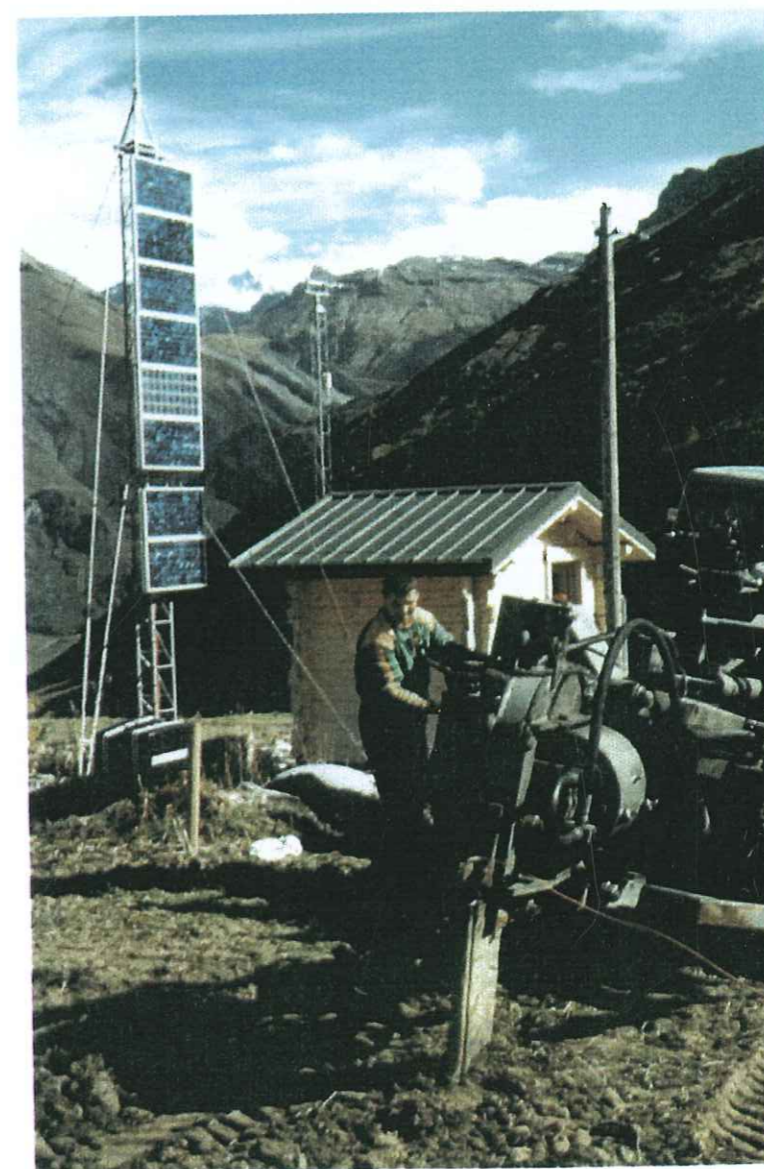
Figure 3.27: Enterrement des câbles électriques à 1 m de profondeur sur la crête de Sur-Frêtes réalisé par un engin spécial.
