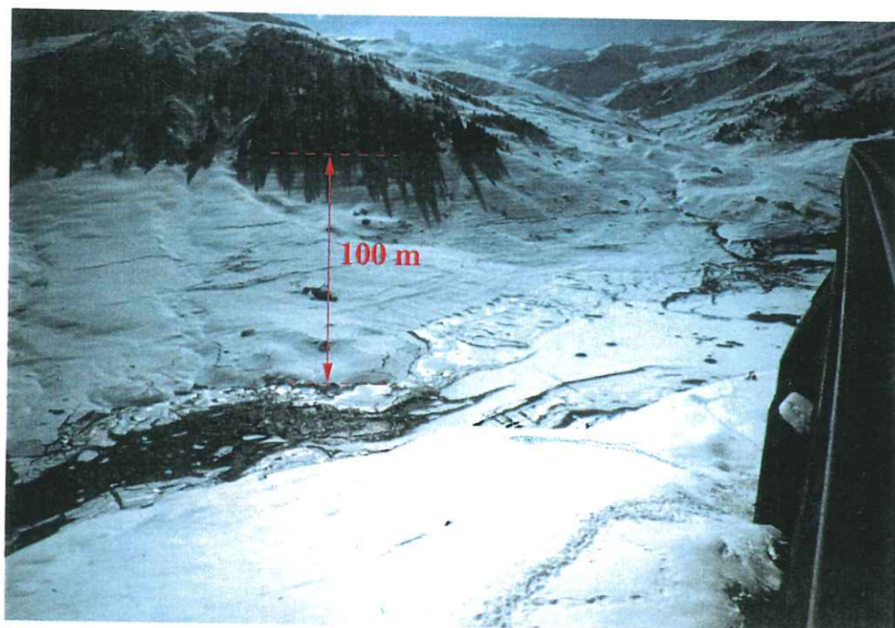
Figure 3.6: Réservoir de Roselend vu le 18/03/99 pendant la vidange. A cette date, le niveau du lac de Roselend est de 1455 m. Le minimum de niveau du lac de Roselend a atteint 1440 m le 10/03/99.
