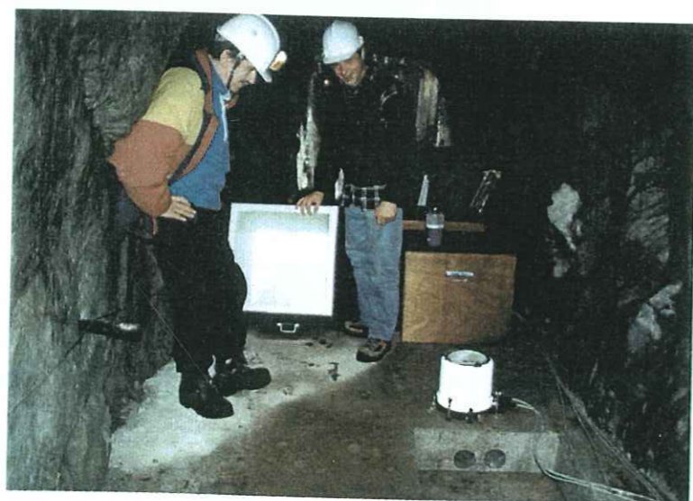
Figure 3.42: Installation de la station sismique SUGF sur une dalle en béton de 20 cm d'épaisseur située à 10 m de l'entrée dans la galerie de Roselend.
