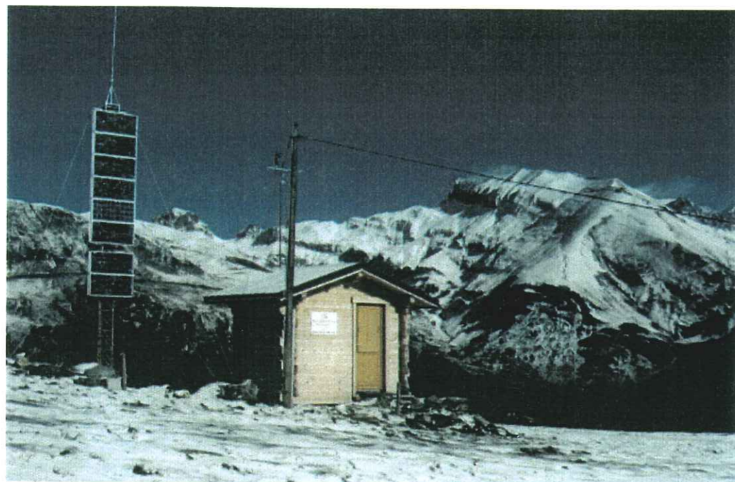
Figure 3.26: Chalet de la crête de Sur-Frêtes (1794 m) où sont enregistrées les données électriques, magnétiques et météorologiques.
