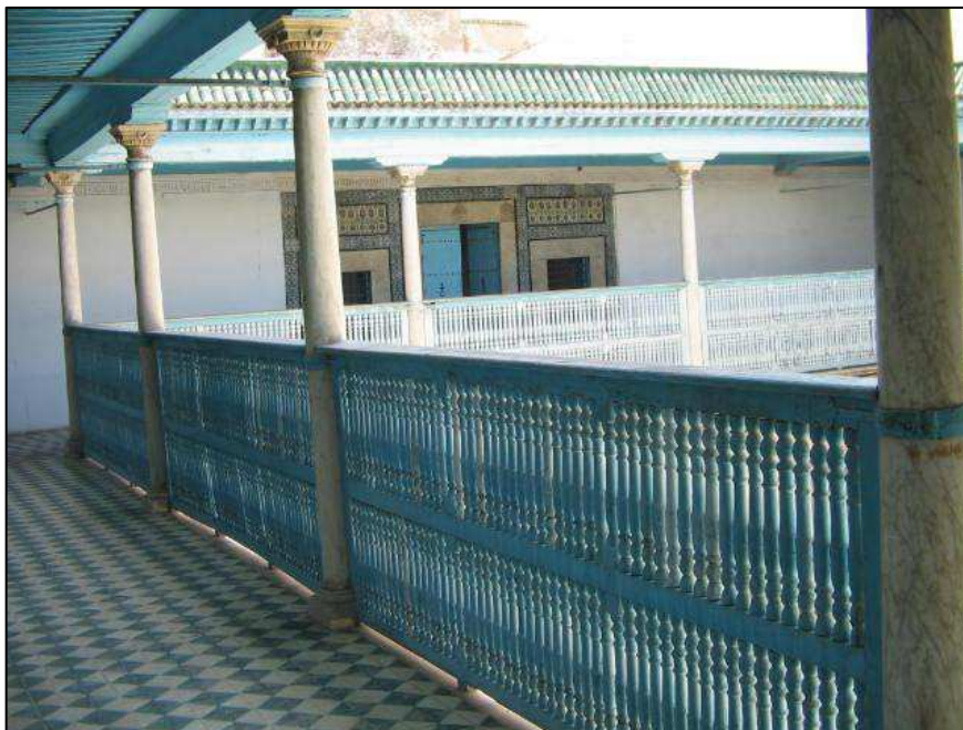
Figure 127 La balustrade du dâr Ben Abdallah
