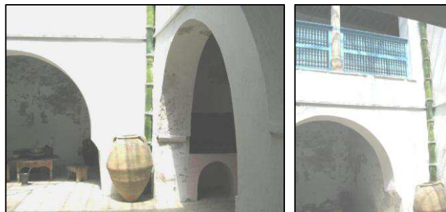
Figure 197 L'état actuel de la cuisine
