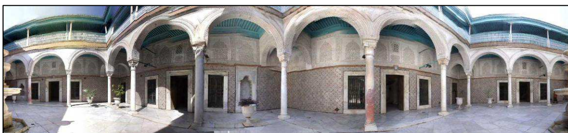
Figure 46 Façades des appartements intérieurs disposés autour du patio
