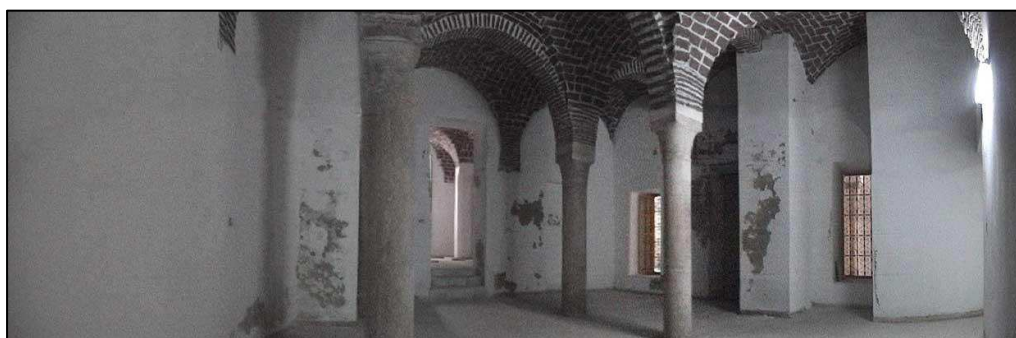
Figure 36 Les makhzen(s) voûtés du dār Lasram
