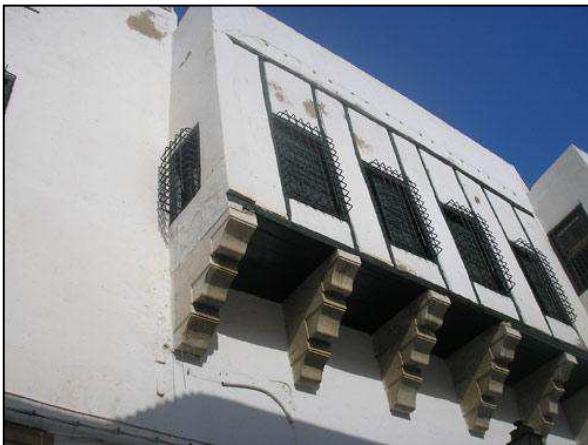
Figure 143 Encorbellement du dâr Lasram
