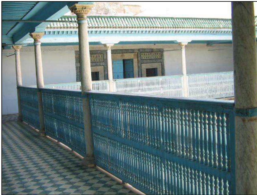
Figure 127 La balustrade du dâr Ben Abdallah
