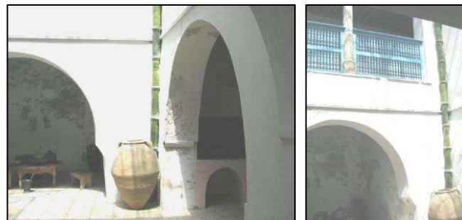
Figure 197 L'état actuel de la cuisine
