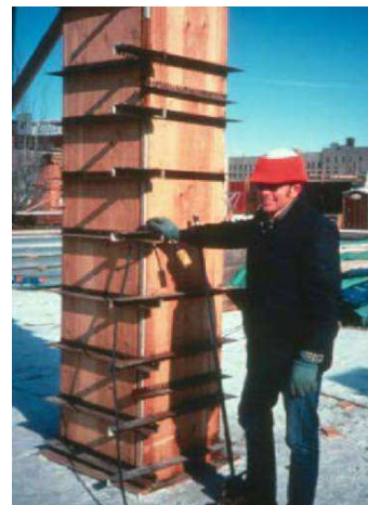
Figure I-45: Maintien des coffrages en place
