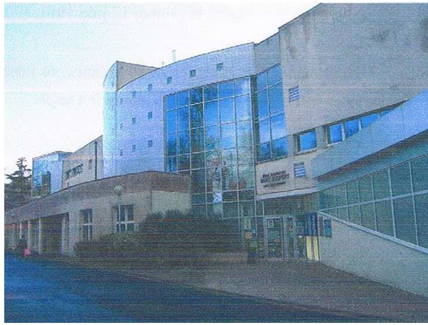
Figure 157. Ecole primaire SAINT-EXUPERY côté entrée, 2006, Photo JCL, Archive USGT
