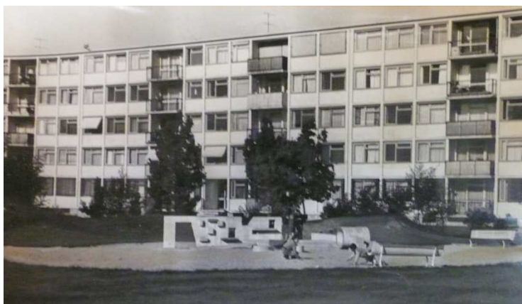
Figure 129. Aire de jeux en béton dans square de Sablons, 1958 Archives de l'IFA
