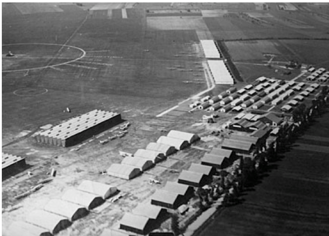
Figure 92. Vue aérienne du terrain d'aviation de l'école de pilotage de Châteauroux vers 1917. Deux blocs de six hangars Bessonneau pour les réparations, plus loin, les baraques destinées au personnel et au casernement des pilotes. A gauche, deux hangars rectangulaires pour remiser les avions.
