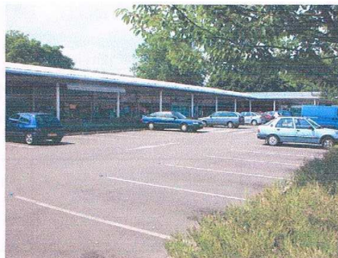
1995 – Vue du parking
