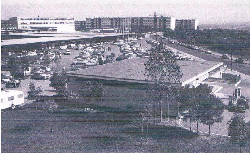
Figure 152. Parking du centre commercial avec station-service, 1962, Photo MIMM Impression, Archives USGT
