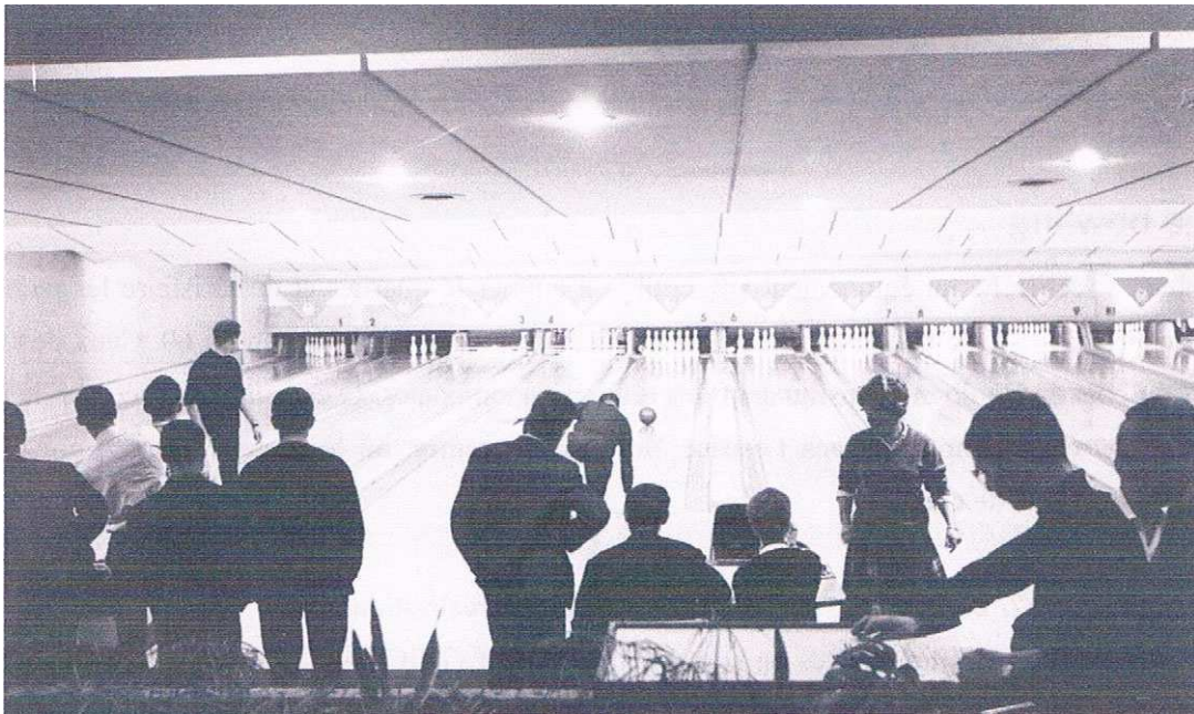
Figure 159. Vue intérieure du bowling, 1960, Photo MIMMI Impression, Archive USGT
