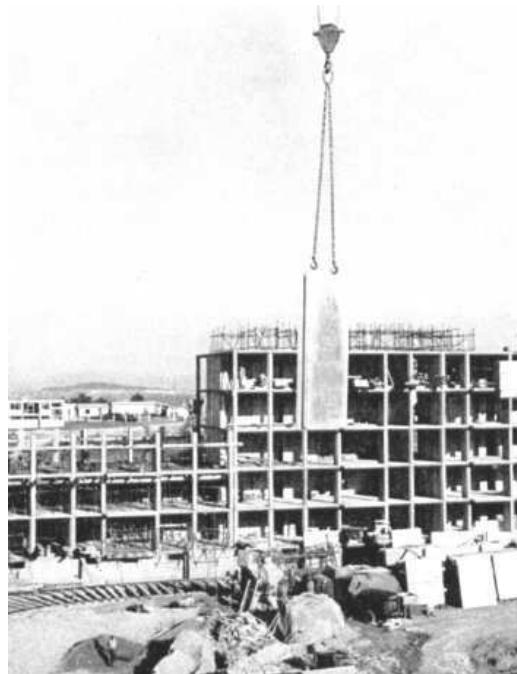
Figure 119. Mise en place à la grue des panneaux de façade préfabriqués, Archives de l'IFA
