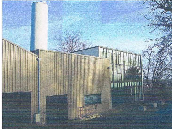
Figure 145. Atelier magasin et bureaux de la chaufferie, 2006, Photo JCL, Archives USGT.
