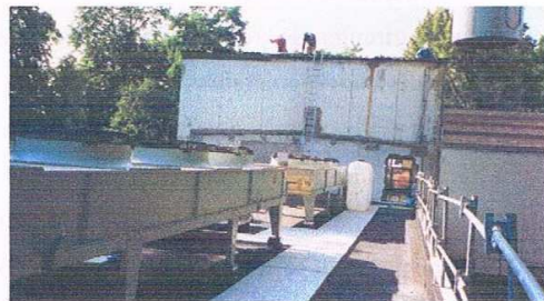
Septembre 1999 - Installation des aéro-refroidisseurs Photo Archives USGT
