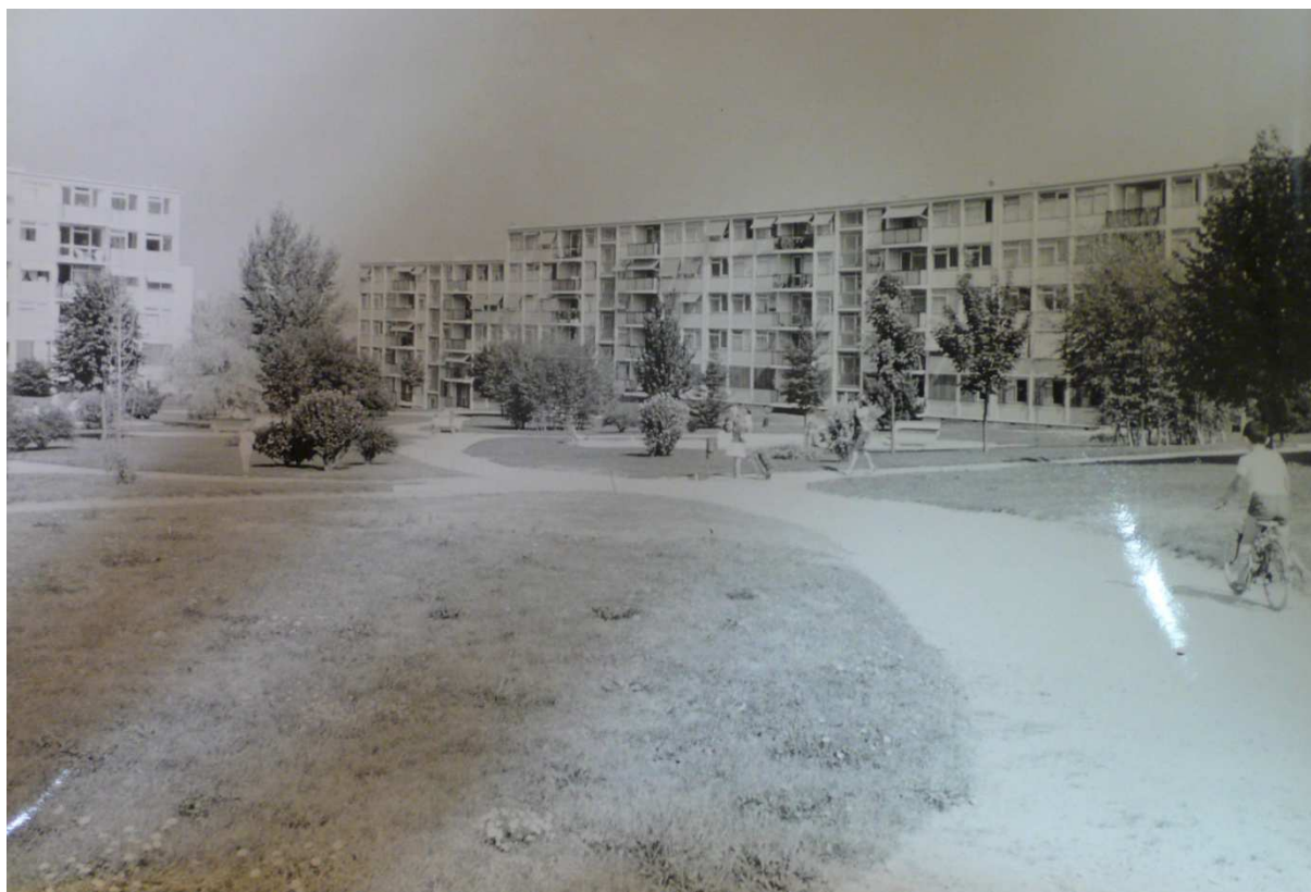
Figure 141. Vue du square des Sablons montre la liberté des piétons, aucune voiture n'y pénètre, 1958, Archives de l'IFA
