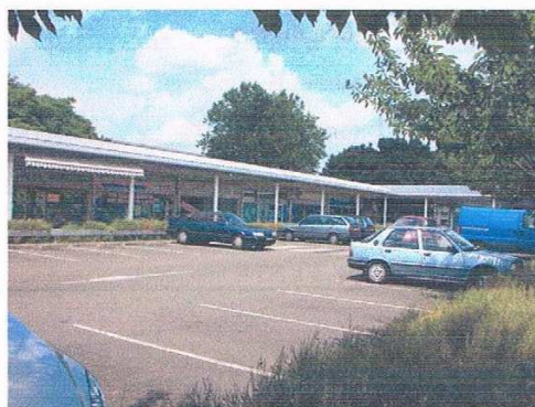
1995 – Vue du parking
