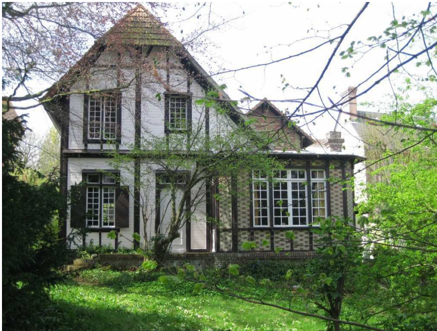
Figure 171. Chalet préfabriqué présenté par l'ingénieur Martin à l'Exposition de 1878 monté à Neuilly puis déplacé à Villiers fin XIXe siècle 544 .
