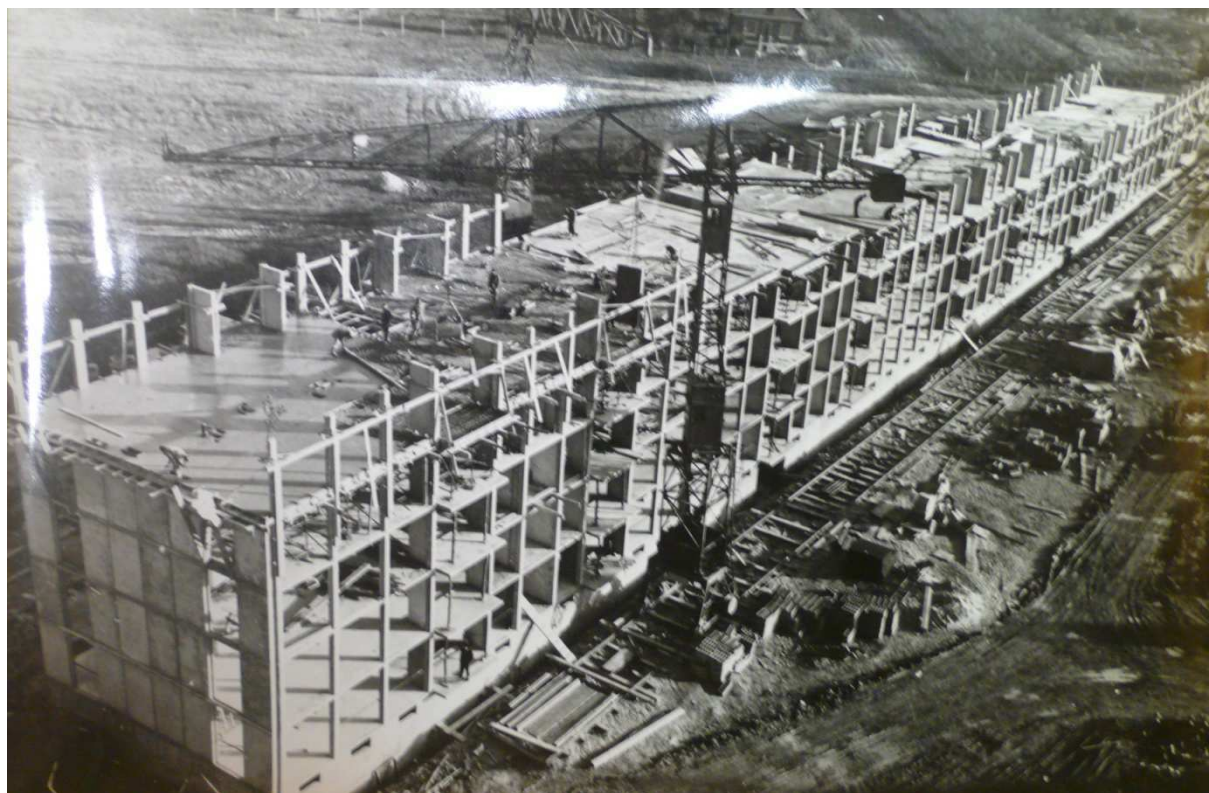
Figure 121. Construction des bâtiments des Grandes Terres, 1957, Archives de l'IFA
