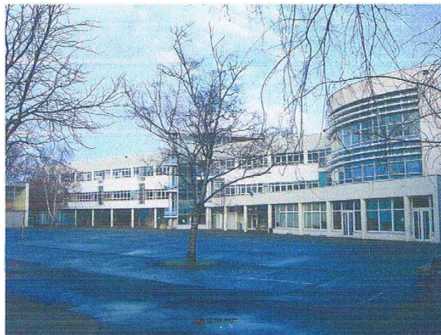
Figure 156. Ecole primaire SAINT-EXUPERY côté cour, 2006, Photo JCL, Archive USGT
