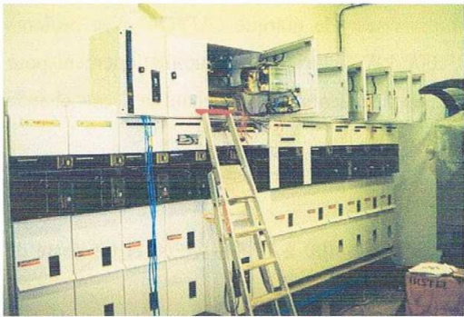
Septembre 1999 - Installation des armoires de télésurveillance - Photo Archives USGT
