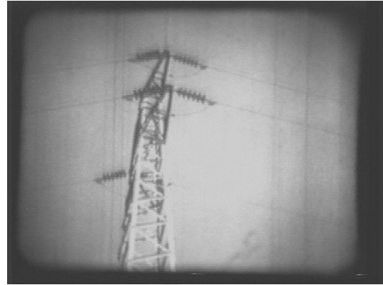
Ph. 47 Isolement du pylône ( Il canale degli angeli )
