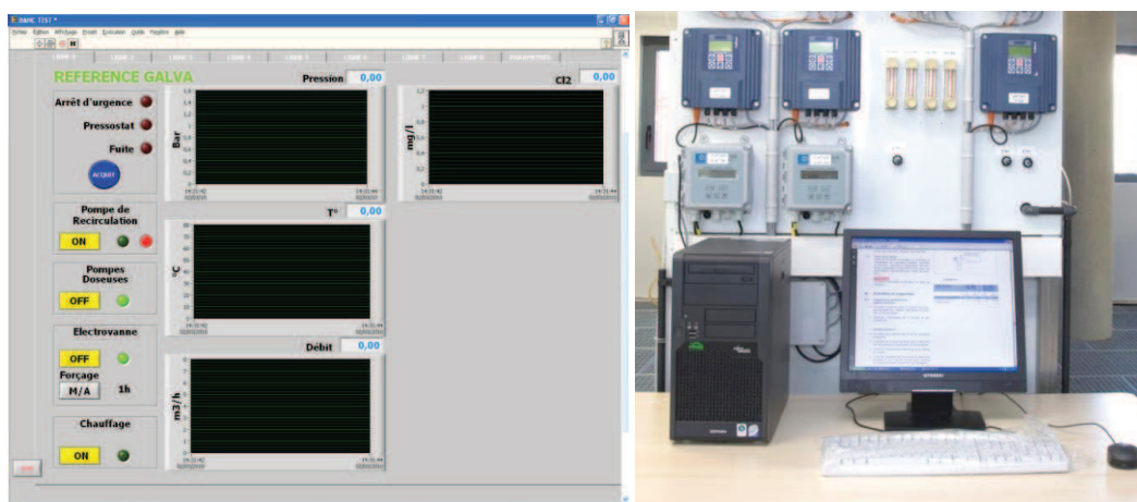
Figure 83 : Ecran de pilotage et supervision de la ligne de référence en acier galvanisé (a). Poste de pilotage (b).
