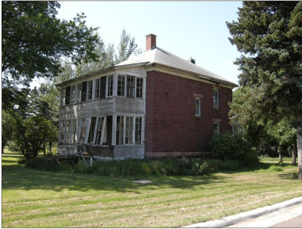
Figure 57 : Maison du surintendant de Pipestone au Minnesota (cliché personne C.L)
