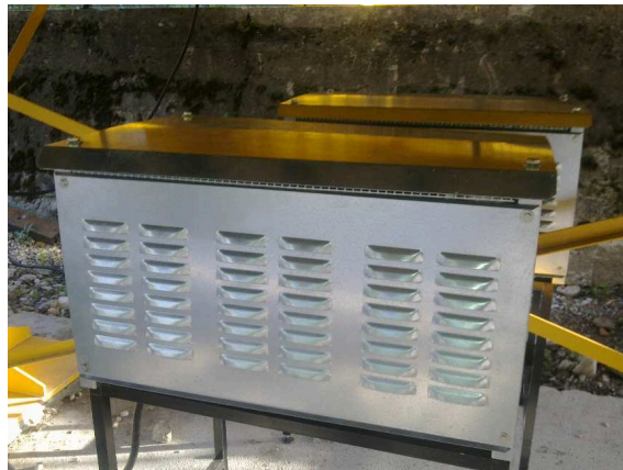
FIGURE IV.16 – Résistances de dissipation
