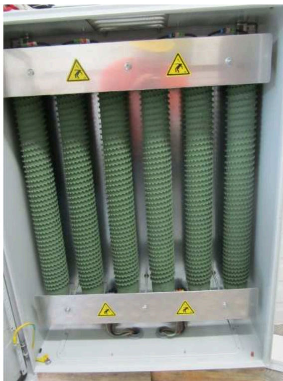
FIGURE IV.17 – Résistances de court-circuit
