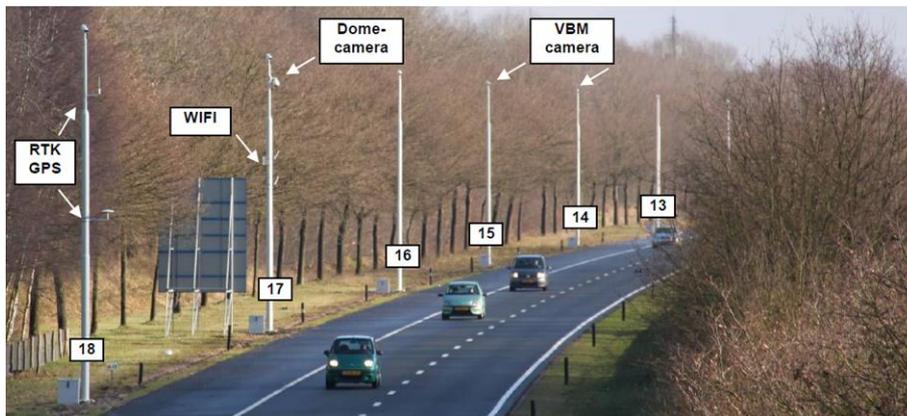
(b) Imagen con los postes, cámaras, RSU, antenas y GPS RTK junto a la autovía (Kwakkernaat, 2011)
