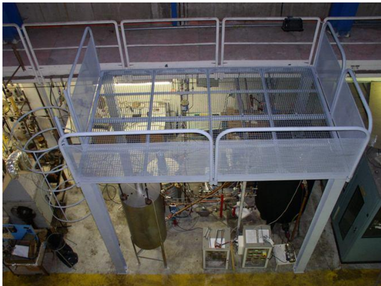
Figure 146 La passerelle sur laquelle prendra place la nouvelle installation « réacteur à bulles »
