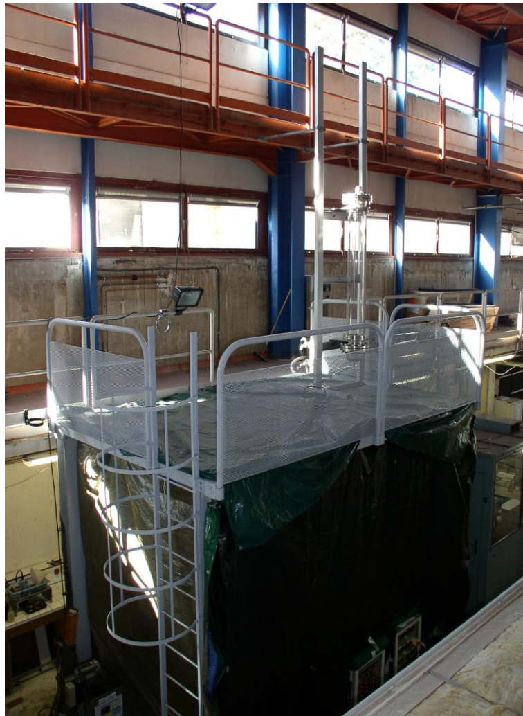
Figure 213 La mise en place du nouveau générateur d'hydrates sur la passerelle (le reste de l'installation étant bâché pour la préserver du froid hivernal)
