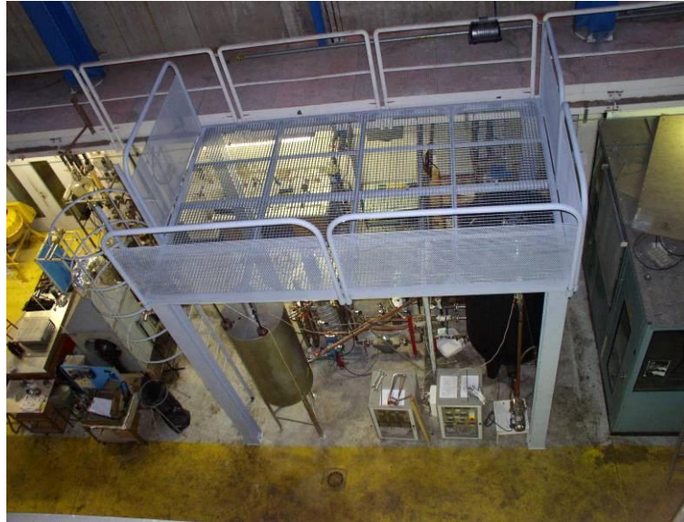
Figure 212 La construction de la passerelle au dessus de l'installation (la cuve chaude a été rajoutée)
