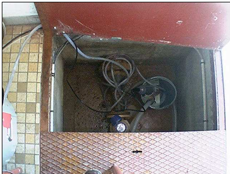
Photo I. 7 – Mise en place de la sonde multiparamètres.
