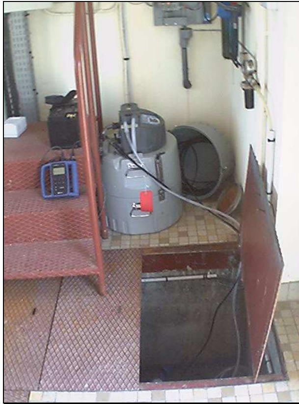
Photo I. 6 – Préleveur automatique dans le local technique du forage de Saint Maurice d’Etelan.
