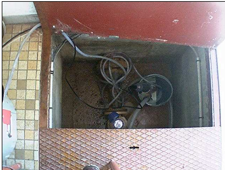
Photo I. 7 – Mise en place de la sonde multiparamètres.
