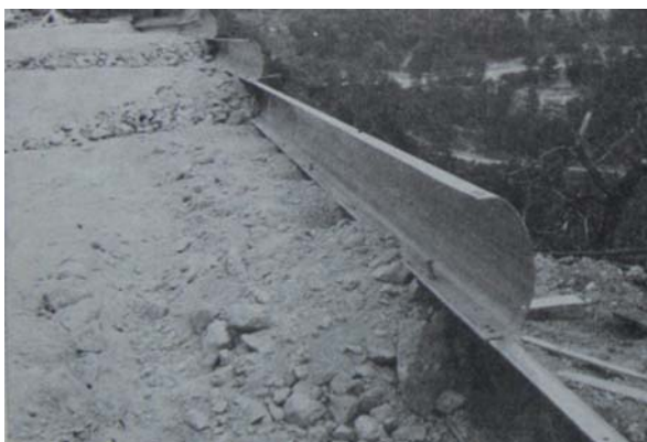
Fig. 95 – Première peau destinée à retenir la terre près du parement. D'après Vidal (1972).
