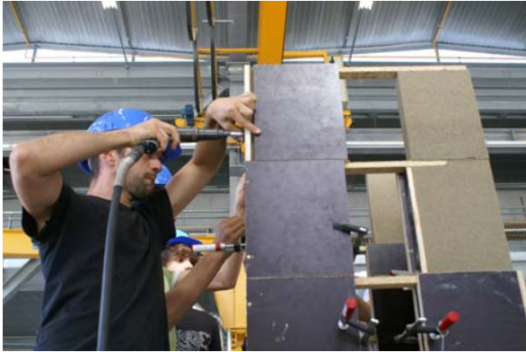
Fig. 107 – La structure est décoffrée en commençant par le haut.
