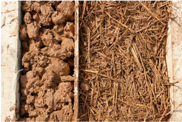
Fig. 54 – Remplissage mixte terre coulée et terre paille.
