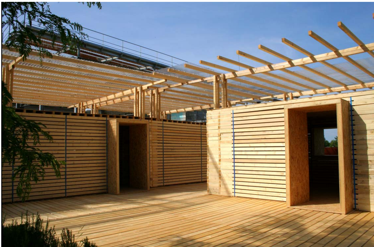
Fig. 37 – Prototype d'habitat très économique pour SDF alliant la terre à pisé et une ossature en bois empilée. D'après Porte (2005).
