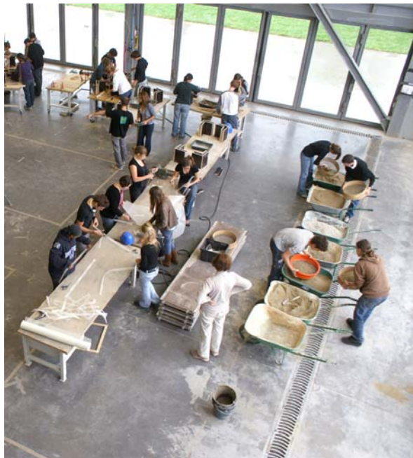
Fig. 111 – Une équipe tamise du sable, pendant qu'une autre découpe les armatures.
