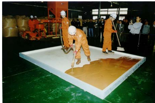
Fig. 12 – Les chercheurs de l'université de Mokpo, en Corée du Sud, réalisent en public de spectaculaires démonstrations de mise en oeuvre de nouveaux bétons d'argile autonivelants. La terre est si fluide qu'elle passe dans un tuyau et qu'elle s'étale comme un liquide. Photo : Heeyong Choi/Mokpo National University.
