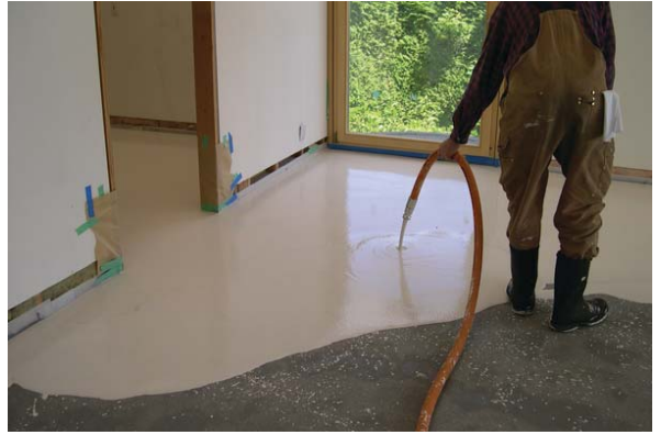
Fig. 14 – Les bétons de ciment autonivelant sont si fluides qu'ils adoptent spontanément une surface horizontale lorsqu'ils sont versés sur le sol. Les secrets de fabrications de tels bétons (répartition granulométrique et ajout de superplastifiant) sont directement transférables au matériau terre. Photo : www.forconstructionpros.com/product/10092085/mapei-corporation-usa-ultratop
