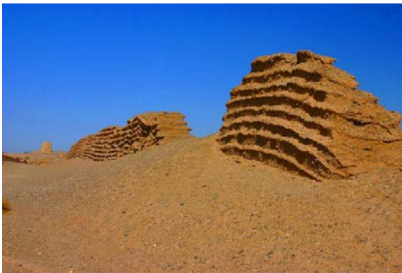
Fig. 64 – Portion de la grande muraille de Chine construite par superposition de lits de granulats et de roseaux.
