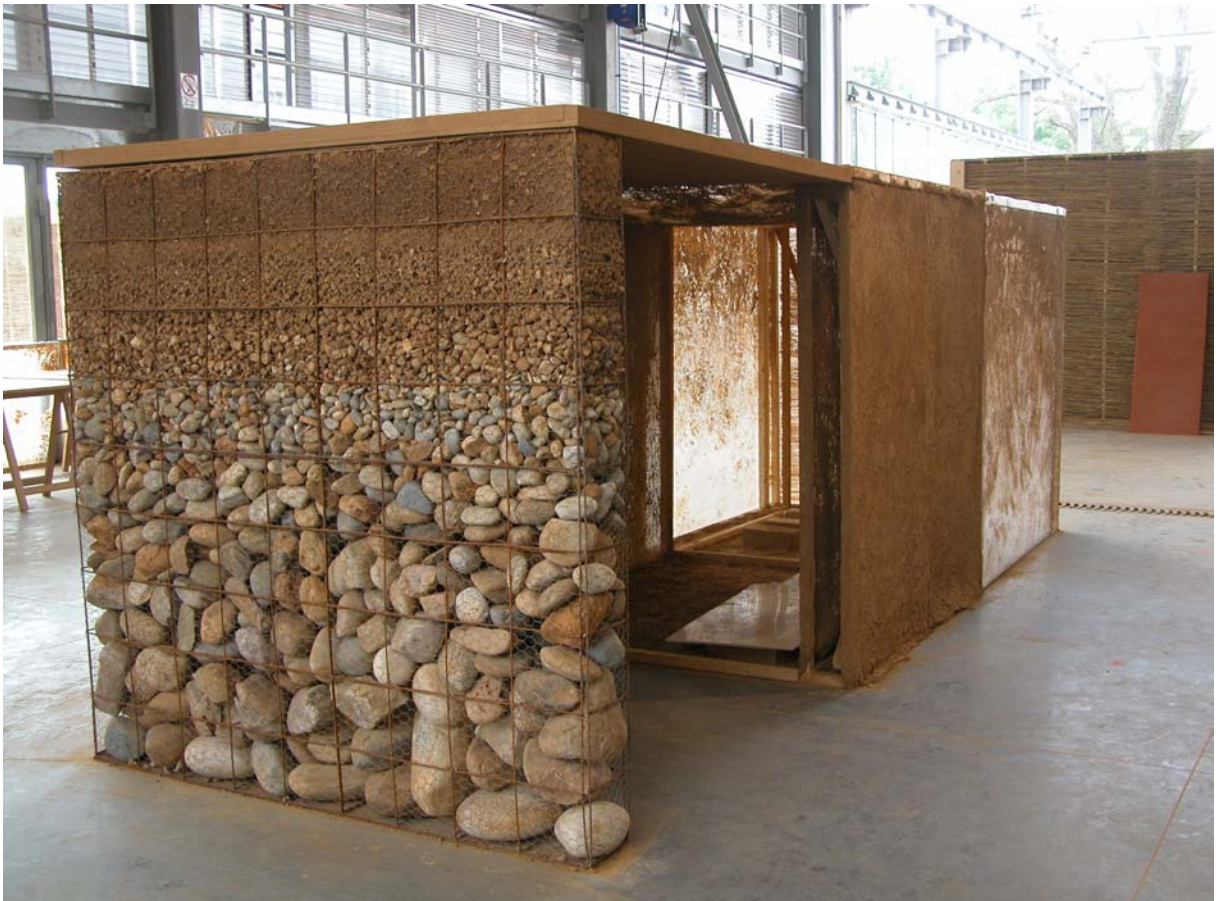
Fig. 71 – Mur en gabion réalisé par des étudiants de l'ENSAG.
