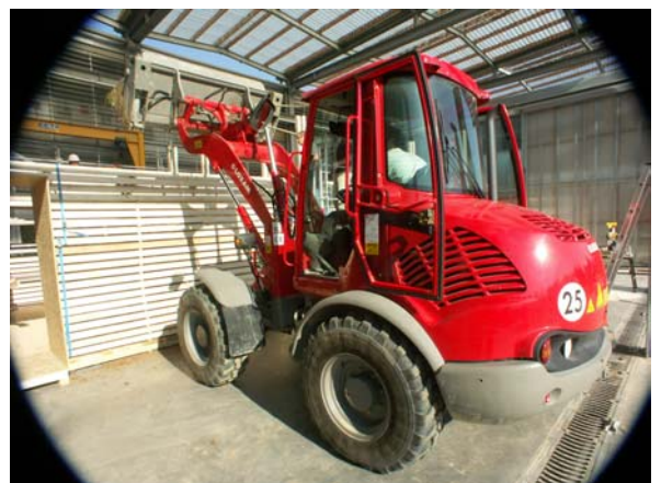
Fig. 41 – Le remplissage très rapide de l'ossature bois s'effectue à l'aide d'un bulldozer. D'après Porte (2005).
