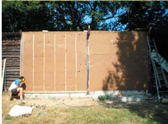
Fig. 7 – Construction d'un lotissement en béton d'argile à Aubenas, en Ardèche, par l'entreprise Caracol. Le matériau a été formulé par Lionel Ronsoux. Photo : Caracol.
