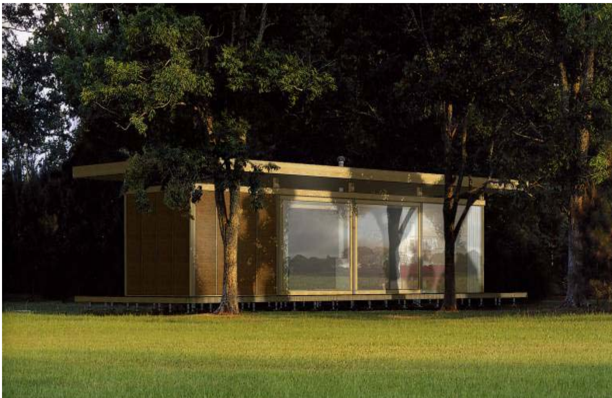
Fig. 1 – Prototype d'habitat léger de loisir alliant la terre à pisé et une ossature en bois légère. D'après Le Tiec (2005).
