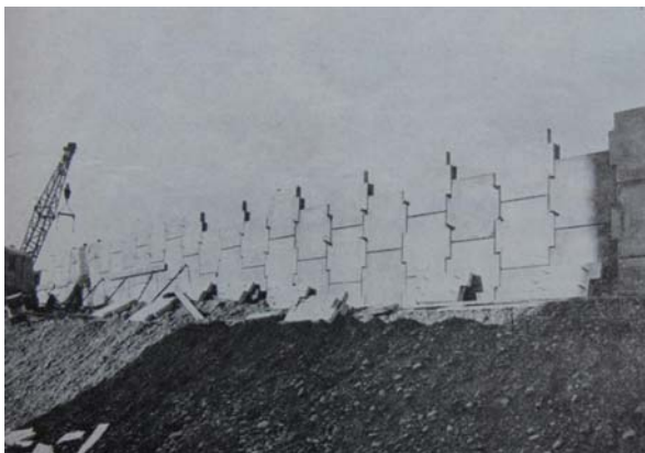
Fig. 97 – La peau est formée d'écailles rigides mobiles les unes par rapport aux autres. D'après Vidal (1972).
