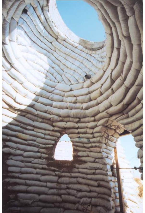
Fig. 73 – Technique des sacs de sable ou superadobe. Photo Nader Khalili.
