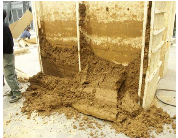
Fig. 15 – Le mur s'effondre une nouvelle fois. D'après Le Tiec (2005).
