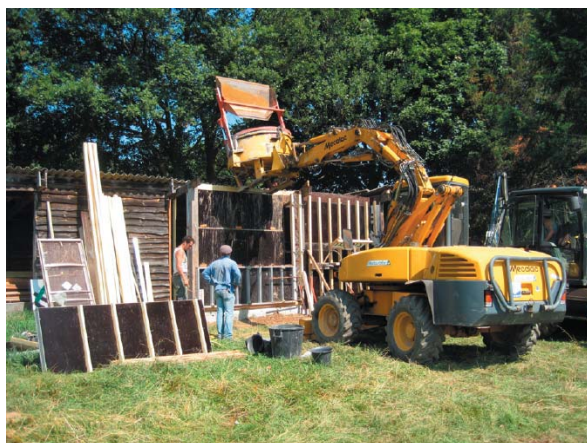
Fig. 6 – Mur en béton d'argile, mis en œuvre à l'état liquide, vibré et coffré, réalisé aux Grands Ateliers par l'entreprise Caracol.
