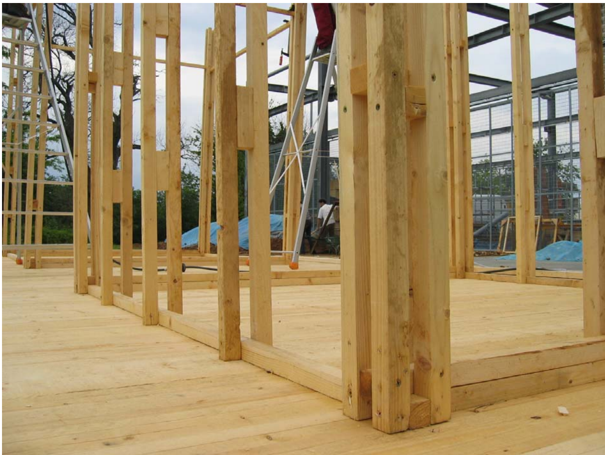
Fig. 4 – La structure en bois est entièrement réalisée à partir d'une section de tasseau de bois unique, de 4x4 cm 2 . Le plancher est constitué de l'assemblage de ces éléments. Les éléments horizontaux moisent les éléments verticaux pour former les poteaux et les poutres. D'après Le Tiec (2005) .
