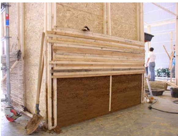
Fig. 14 – La quantité d'eau est réduite et la terre est mise en oeuvre à l'état plastique, une série de liteaux jouant le rôle de coffrage rampant. Le panneau OSB intérieur ne résiste pas à la poussée et se déforme. D'après Le Tiec (2005).
