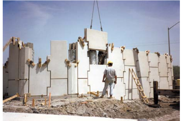
Fig. 89 – Mur en terre armée en construction. Photo : www.recocanada.com/reinforced_earth.php
