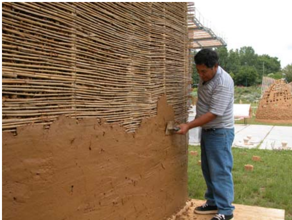
Fig. 32 – Enduit en terre sur la canisse de roseaux. D'après Le Tiec (2005).
