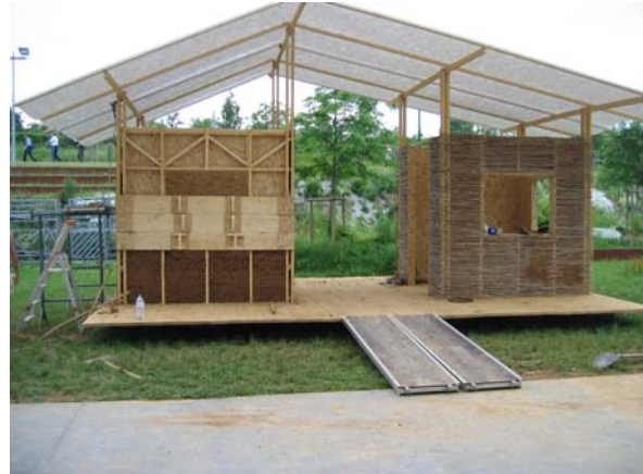
Fig. 25 – A gauche : système léger de coffrage rampant, laissant la terre apparente. A droite : canisse de roseau servant de coffrage perdu. D'après Le Tiec (2005).
