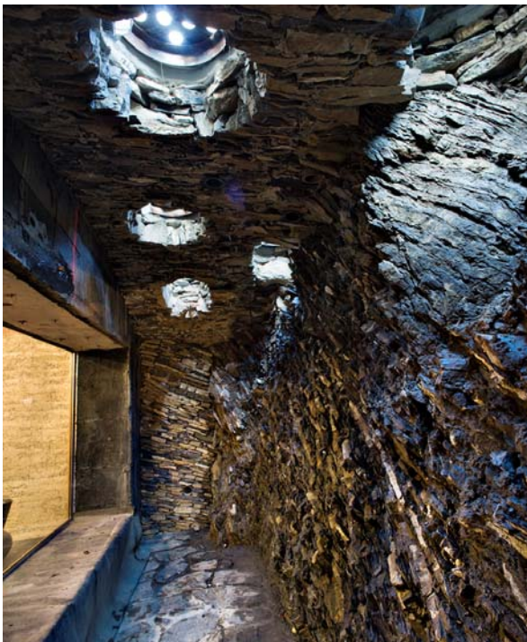
Fig. 114 – Le mur en pisé (à gauche), recouvert de feutre de bitume, n'est pas en contact direct avec la roche excavée. Photo : Martin Rauch.
