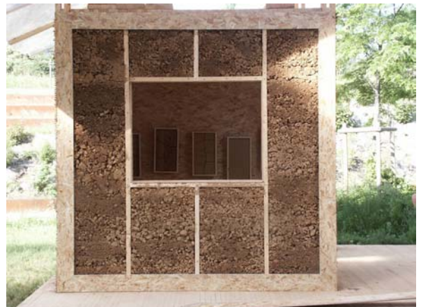
Fig. 31 – Mur terminé. D'après Le Tiec (2005) .
