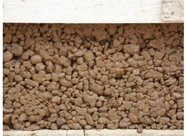
Fig. 30 – Aspect du mur décoffré. D'après Le Tiec (2005) .
