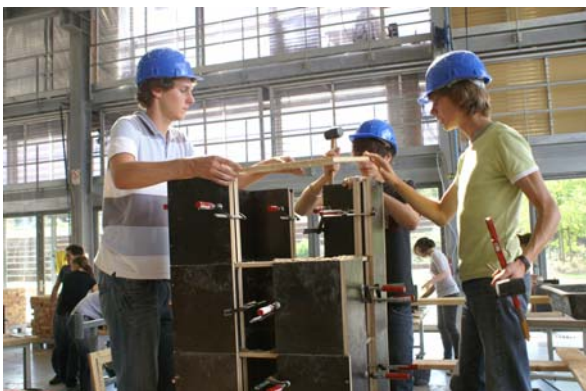
Fig. 105 – Un cadre en bois carré est positionné au sommet et à l'intérieur de 4 coffrages.
