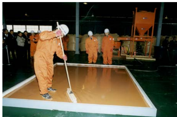
Fig. 13 – Comme pour les bétons de ciment autonivelants, la terre est étalée avec un simple balai. Cette dalle a ainsi été coulée en un temps record. Photo : Heeyong Choi/Mokpo National University.
