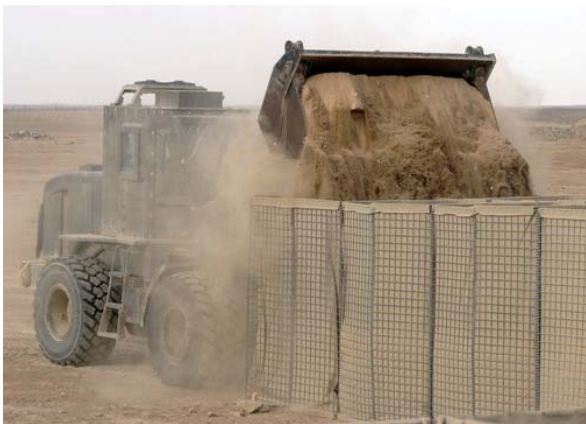
Fig. 75 – Remplissage au bulldozer. Photo : wikimedia commons
