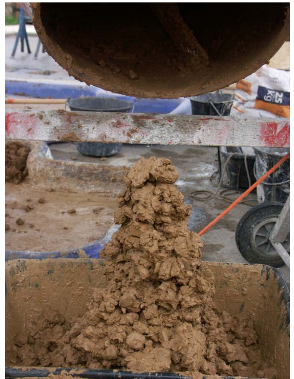
Fig. 21 – Pourtant, à la sortie de la bétonnière, la terre forme une colonne, qui ne s'affaisse pas. D'après Le Tiec (2005) .
