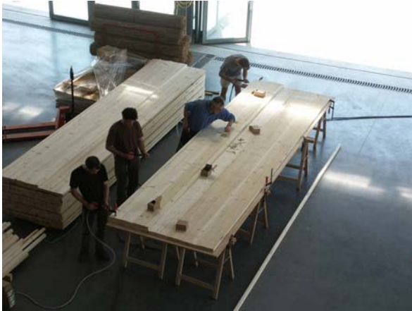
Fig. 5 – Assemblage en atelier des tasseaux de bois pour former le plancher. D'après Le Tiec (2005).
