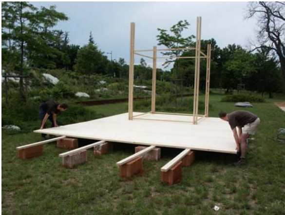
Fig. 6 – Tous les éléments sont légers et transportables, comme par exemple le plancher, posé sur des fondations légères, et le premier cube, qui a été déposé sur le plancher. D'après Le Tiec (2005).
