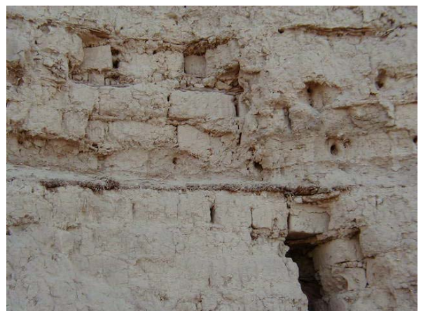
Fig. 67 – Vue rapprochée des rangées de briques et des lits de roseaux. Photo : Silvia Reyes
