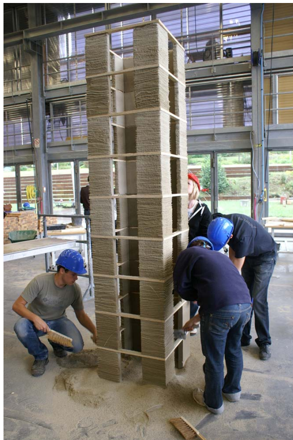
Fig. 109 – La surface est brossée pour faire apparaître les armatures.
