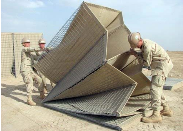
Fig. 74 – Une armature dépliable associée à un textile permet de construire des murailles très rapidement. Photo : HESCO bastion, www.steelwiremesh.net/gabion/hesco-bastion
