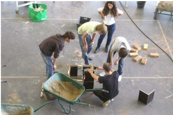
Fig. 104 – Les coffrages remplis sont maçonnés comme des blocs.
