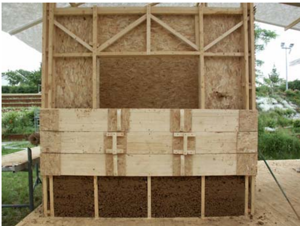
Fig. 28 – Deuxième système de 3 bandes vissées sur l'ossature. La bande du bas est dévissée et refixée au-dessus au fur et à mesure que le remplissage du mur progresse. D'après Le Tiec (2005) .
