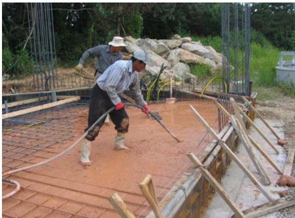
Fig. 10 – La terre est compactée comme un béton à l'aide d'une aiguille vibrante. Photo : Heeyong Choi/Mokpo National University.
