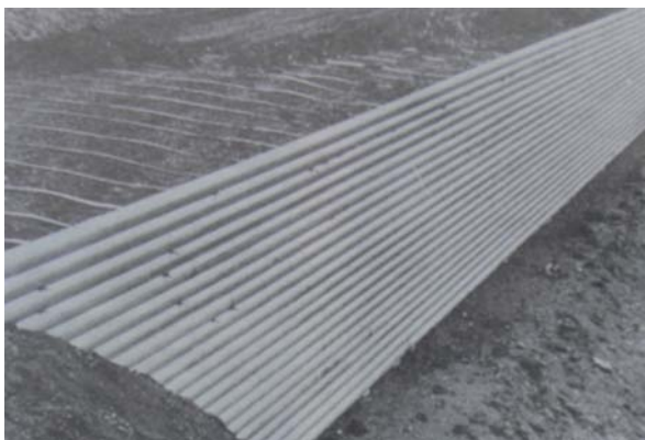
Fig. 96 – La forme courbée de la peau lui donne sa souplesse. D'après Vidal (1972).
