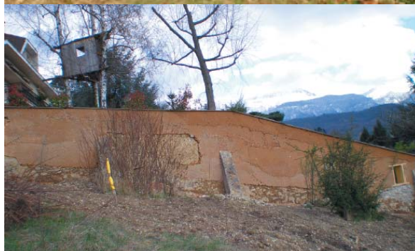
Fig. 5 – Premier chantier en terre coulée réalisé par l'entreprise Caracol pour la restauration d'un mur en pisé. Photo : Caracol.
