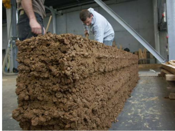
Fig. 56 – Mur monolithique en terre coulée réalisé à l'aide d'un coffrage provisoire de tasseaux de bois empilés.
