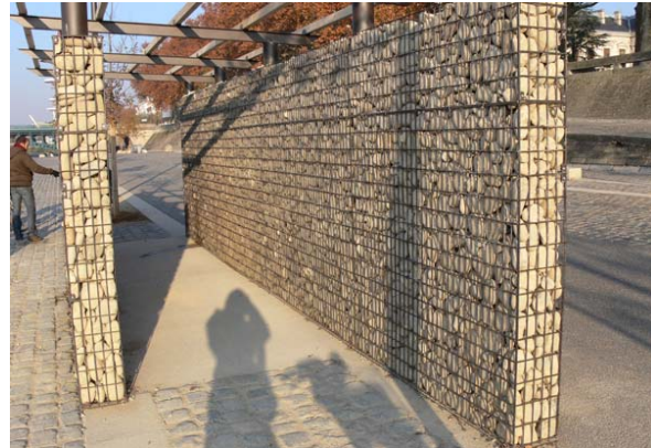
Fig. 68 – Murs en gabion sur les berges du Rhône, à Lyon.
