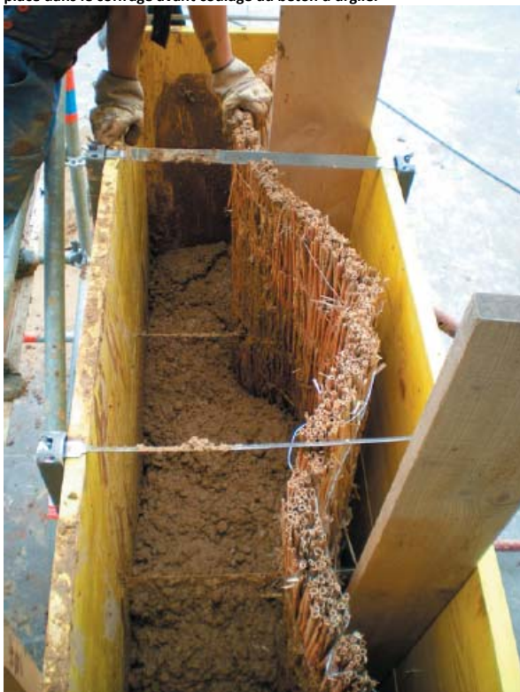
Fig. 17 – Ci-dessous et en bas à gauche, un panneau de roseau isolant est placé dans le coffrage avant coulage du béton d'argile.
