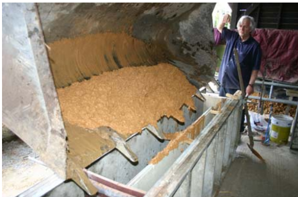
Fig. 2 – Le mélange est versé dans un coffrage à béton. Sa viscosité est proche de celle d'un béton vibrable.
