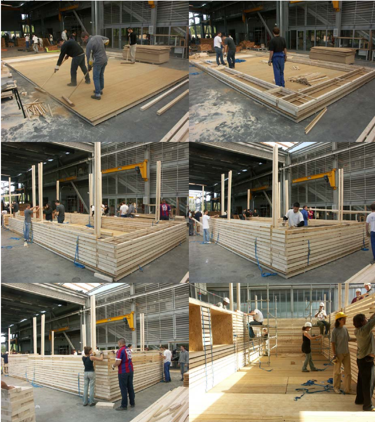
Fig. 42 – Les tasseaux de bois de même section sont empilés les uns sur les autres, sans liant, ni colle, ni système de fixation. Le montage de la structure est très rapide et peut être réalisée par une main d'œuvre non qualifiée. D'après Porte (2005) .
