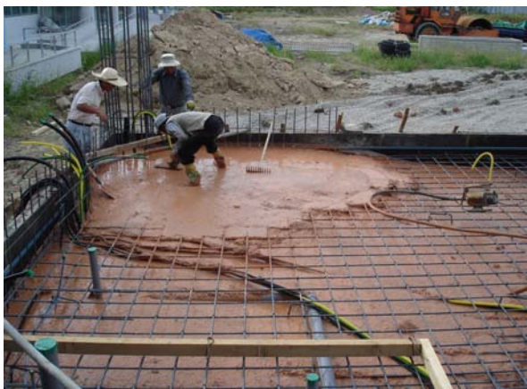
Fig. 11 – La terre est étalée et lissée à l'aide d'une taloche. Photo : Heeyong Choi/Mokpo National University.
