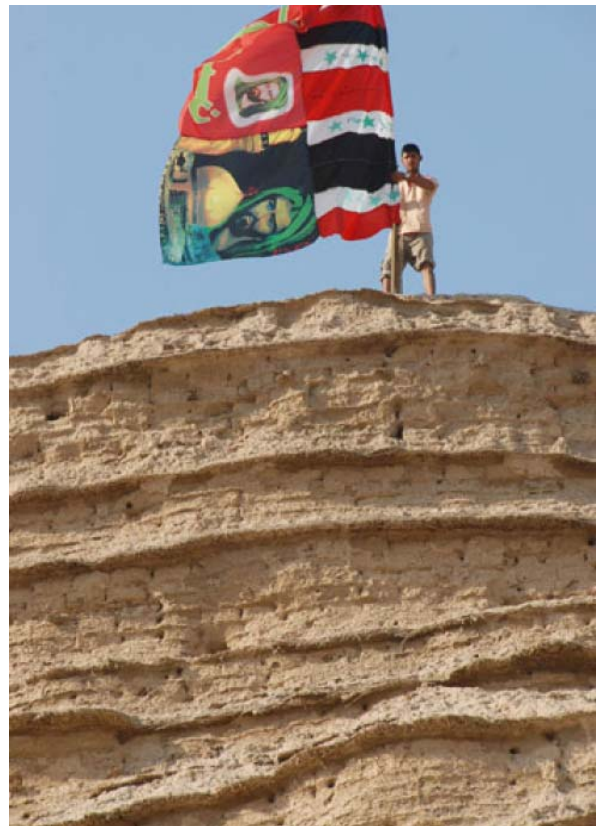
Fig. 66 – Nattes de roseaux insérées entre les briques toutes les cinq rangées environ. Photo : Travis J. Tritten http://www.stripes.com/news/resurrecting-the-ruins-of-aqar-quf-1.87451 .
