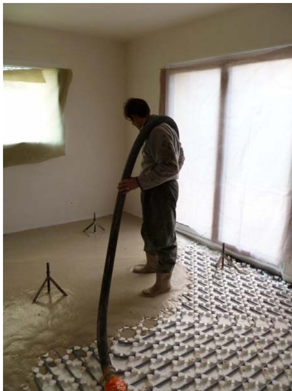
Fig. 19 – La mise en œuvre de la terre liquide peut permettre la réalisation de chapes autonivelantes pour la réalisation de planchers isolants et chauffants. Photo : http://www.multi-chapes.com/chapes.php
