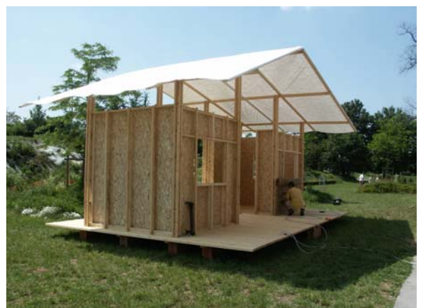
Fig. 10 – L'ossature en bois est terminée. Le remplissage des murs avec de la terre peut commencer. D'après Le Tiec (2005).
