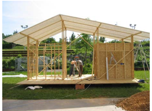
Fig. 9 – Les faces intérieures des cubes sont fermées par des panneaux légers d'OSB. D'après Le Tiec (2005).
