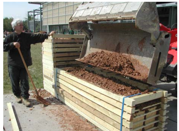
Fig. 53 – Remplissage avec du pisé coulé.
