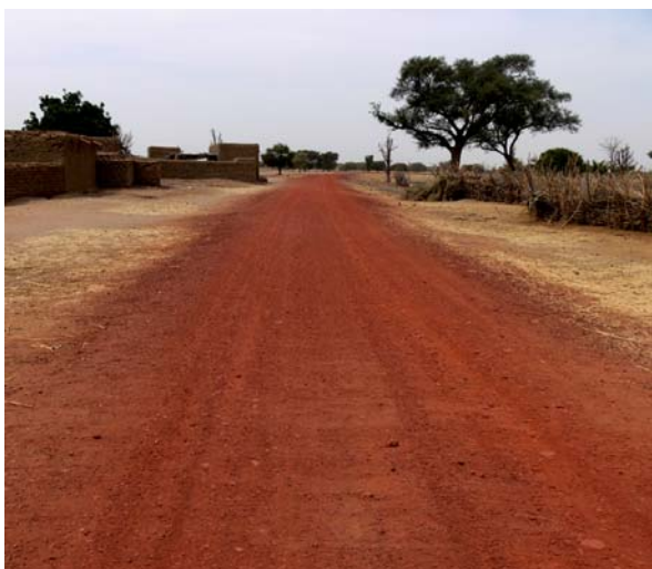
Fig. 9 – La cuirasse latéritique est utilisée comme granulats pour les pistes, comme ici au Mali.
