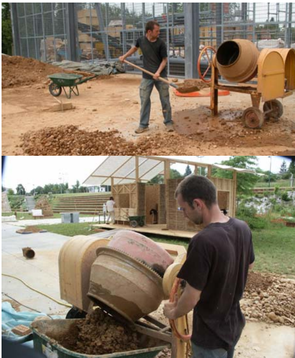
Fig. 20 – Le mélange de gros granulats et de fines est facile à malaxer dans une bétonnière, comme une terre liquide. D'après Le Tiec (2005) .
