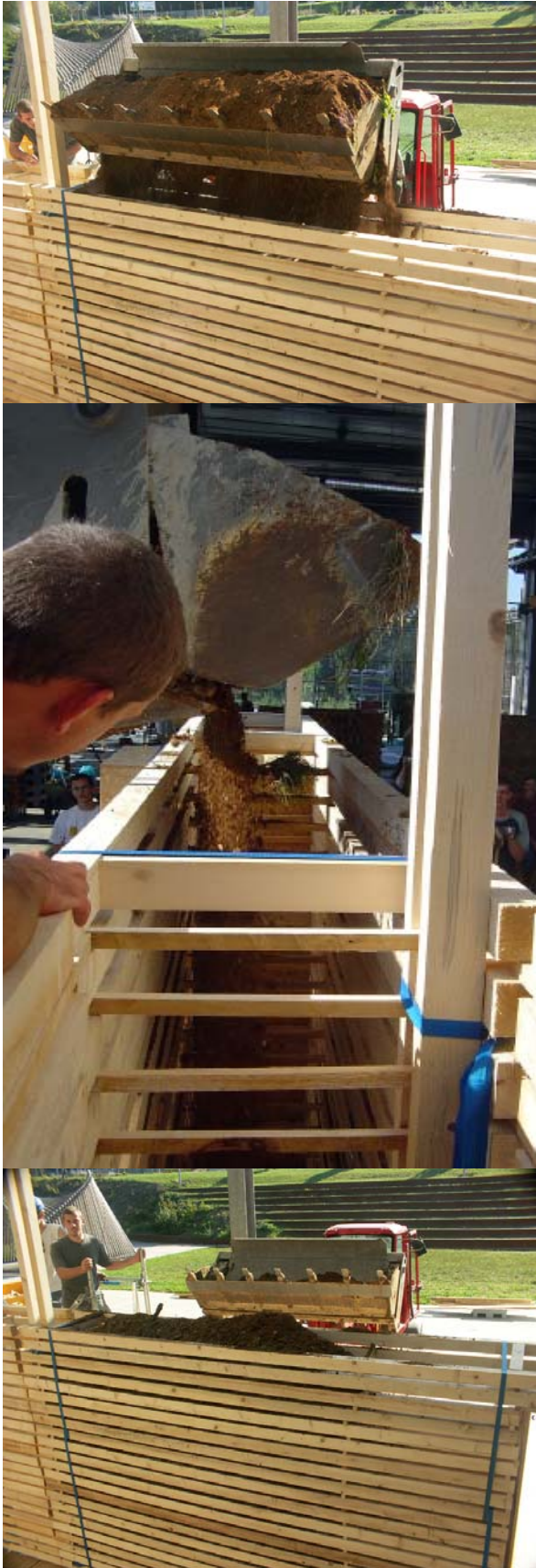
Fig. 44 – Remplissage au bulldozer. D'après Porte (2005).
