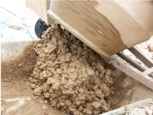
Fig. 22 – Vue du matériau à la sortie de la bétonnière. D'après Le Tiec (2005).
