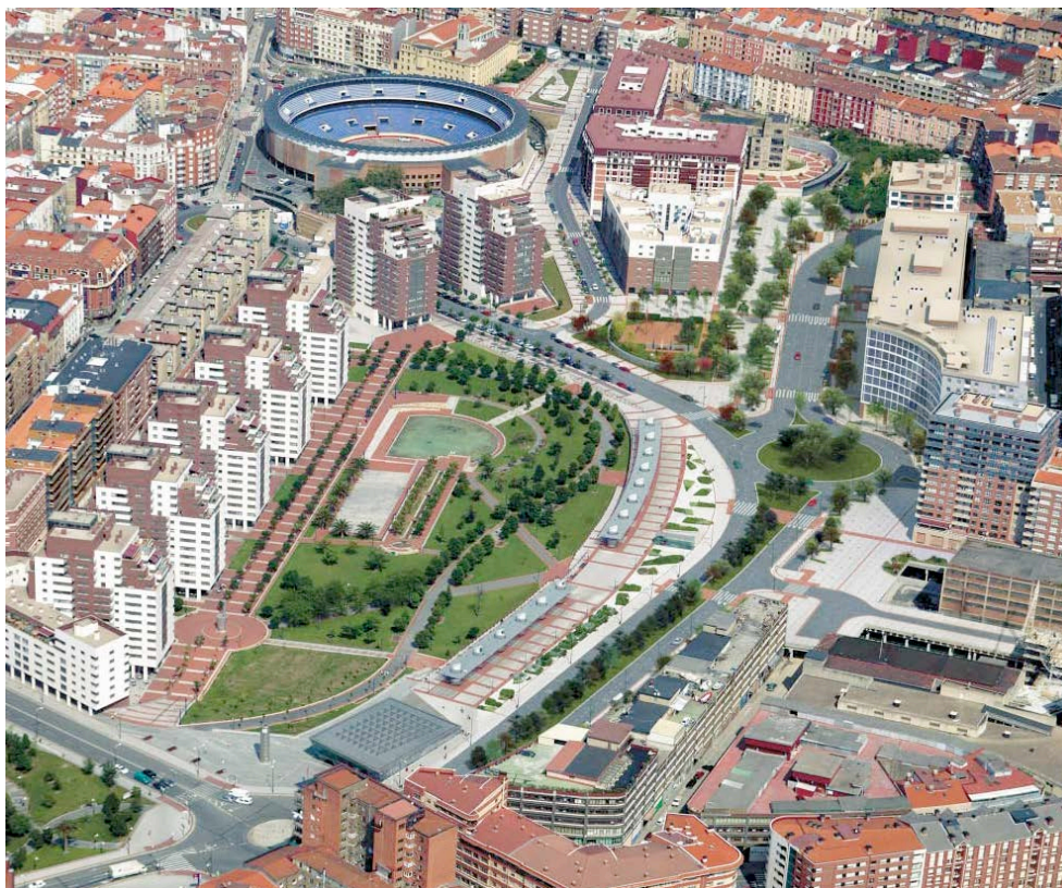
Figure 146 – Vue aérienne du quartier d'Ametzola, mettant en évidence le parc et sa nouvelle extension vers le sud-ouest au-delà de l'Avenue Gordoniz, les tours de logements de l'opération immobilière à l'origine de ce développement, la nouvelle gare d'Ametzola et l'Avenue du Ferrocarril récemment couverte. L'on distingue en particulier les nouveaux espaces arborisés, très généreux, gagnés en faveur du piéton. © Bilbao Ria 2000. BR2000 n°11, juin 2005, p. 25.
