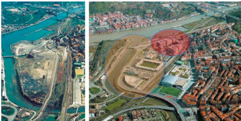
Figure 163 - La transformation du site de Galindo (ellipse orange) et de l'un des quartiers centraux de Barakaldo qui fait l'objet du programme Européen de régénération urbaine URBAN (ellipse rouge). Situation avant-après.
