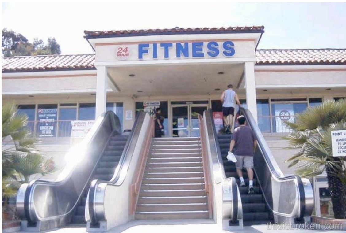
Figure 4 - Les installations sportives elles-mêmes pâtissent parfois d'un aménagement qui n'incite pas à la pratique de l'activité physique. Ici, un fitness à San Diego aux Etats-Unis. Son accès qui privilégie les escalators plutôt que les escaliers est en patente contradiction avec la vocation première du lieu. Source : http://ninfield.files.wordpress.com/2010/05/san-diego-gym.jpg
