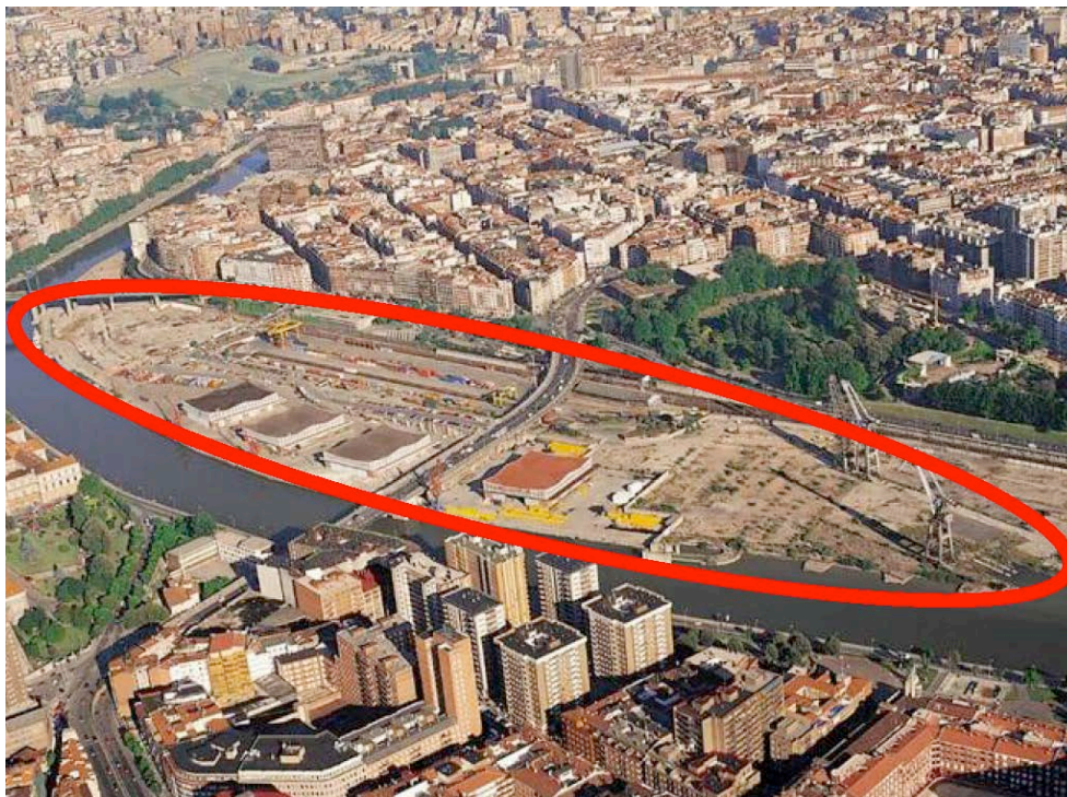
Figure 150 – Vue aérienne du site d'Abandoibarra en friche. L'on perçoit clairement en arrière-plan la nette coupure linéaire introduite par la voie rapide Agirre Lehendakariaren Etorbidea, qui coupe la ville en deux tissus urbains distincts : à l'est, la maille orthogonale serrée de l'Ensanche, à l'ouest le parc Dona Casilda Iturrizar.
