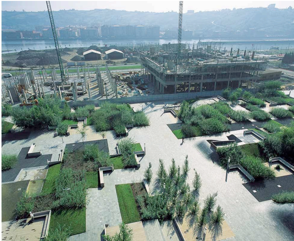
Figure 165 – Bilbao Ria 2000 a mis la place del Desierto à disposition du public, avant même que les immeubles environnants soient achevés. Elle est ainsi devenue d'emblée une centralité et un nœud de repérage pour les nouveaux habitants, mais aussi pour les citoyens des quartiers environnants. © Bilbao Ria 2000. BR2000 n°4, novembre 01-avril 02, p. 25.
