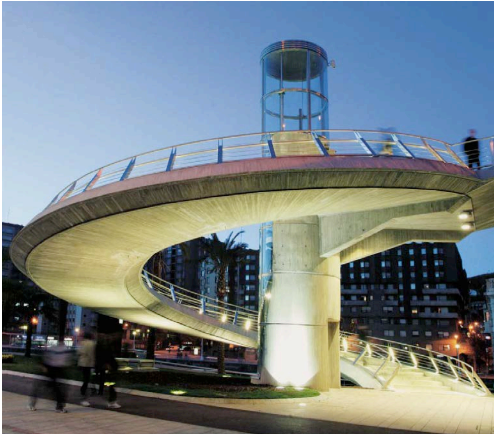
Figure 141 – L'attractivité des escaliers est encore rehaussée la nuit par une mise en lumière innovante, qui sait mettre en valeur les courbes fines de cette infrastructure hélicoïdale. © Bilbao Ria 2000. BR2000 n°8, décembre 03, p. 11.
