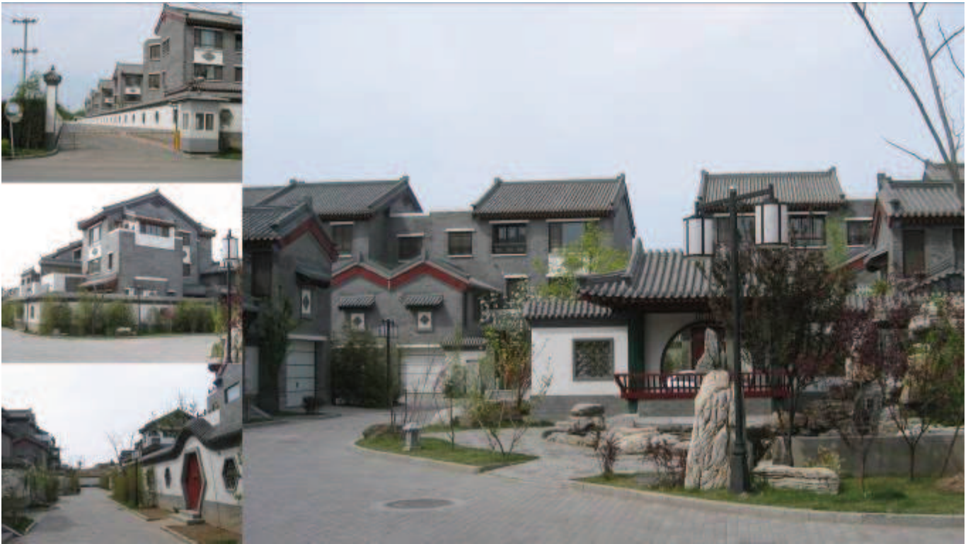
Résidence Cathay Villa, à l'est du site des jeux Olympiques reprenant l'architecture traditionnelle chinoise.
