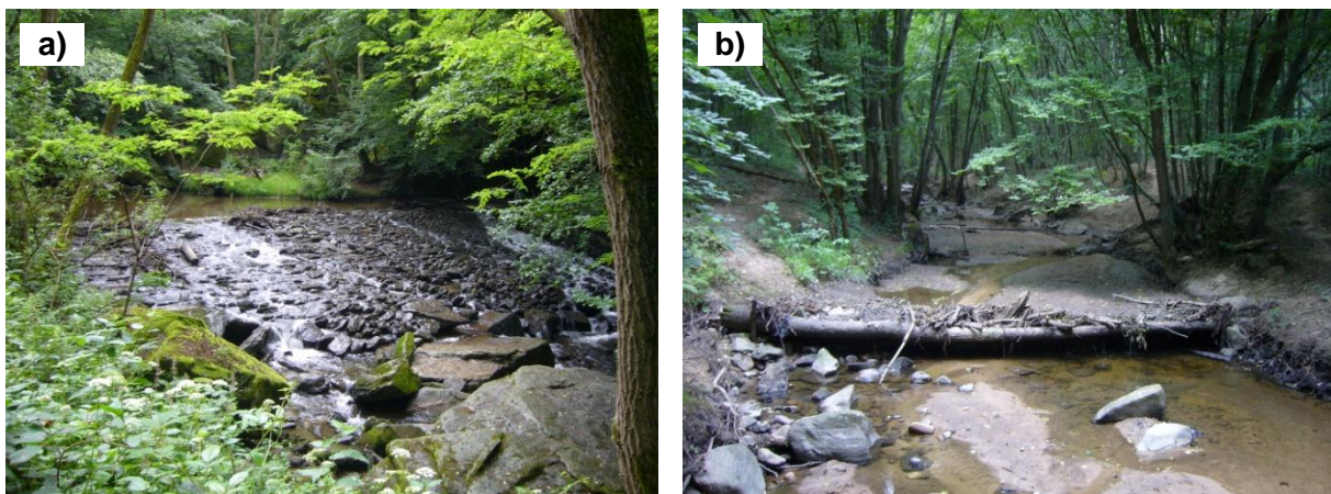
Figure 44 : exemples de seuils artificiels : a) seuil maçonné du Moulin du Gault d'une hauteur d'environ 3 m ; b) seuil en rondin d'une hauteur d'environ 0,3 m installé par l'association locale de pêche
