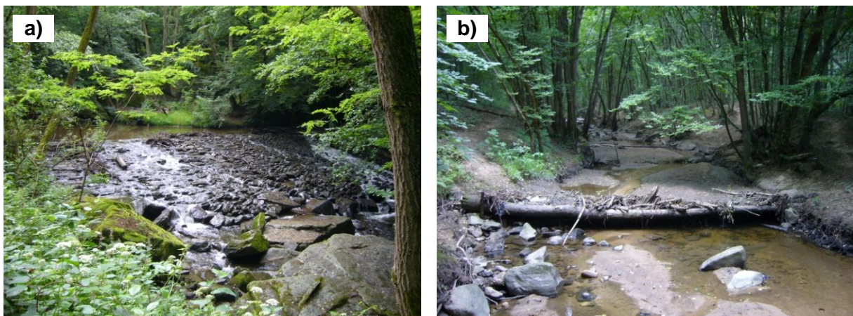
Figure 44 : exemples de seuils artificiels : a) seuil maçonné du Moulin du Gault d'une hauteur d'environ 3 m ; b) seuil en rondin d'une hauteur d'environ 0,3 m installé par l'association locale de pêche
