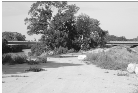
Figure I-2 : Vue sur les digues de protection du Rhône, vers Arles.
