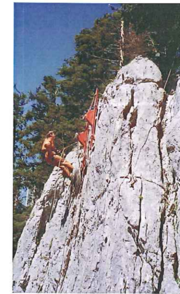
Figure IV.B-5 Technique adoptée pour la descente en paroi d'une antenne radar
