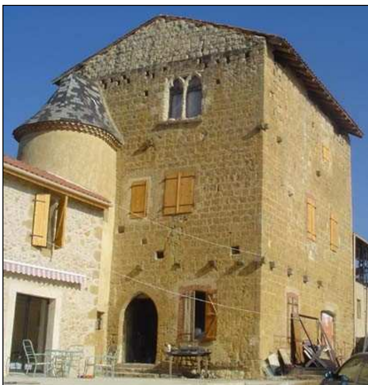
Fig. 65. - Photographie de Lassalle à Lamazère, vue depuis le sud.
