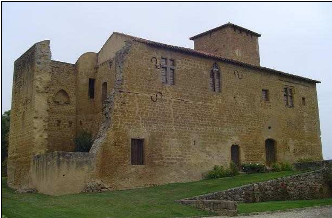
Fig. 79. - Photographie de la façade orientale du château de Garrané, commune de Seissan (XII e -XIV e siècles).
