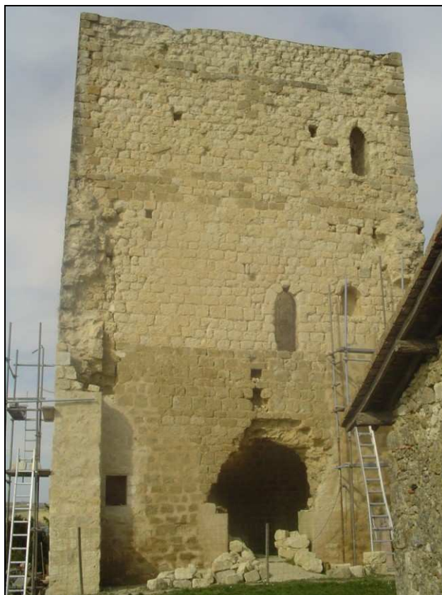
Fig. 75. - Photographie de la façade sud-est de la tour de Lagouarde (commune de Lartigue) avec traces d'arrachement des murs appartenant à la salle attenante disparue.
