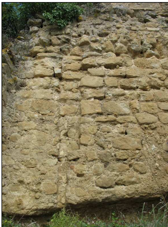
Fig. 44. - Photographie de détail du mur extérieur méridional de la tour à contreforts montrant l'appareillage de la construction et l'un des deux négatifs repérés.
