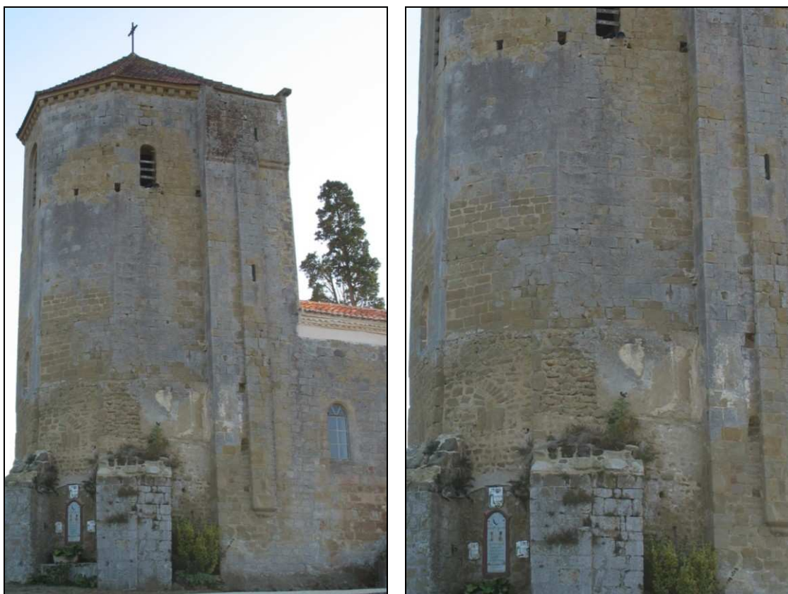
Fig. 27. - Photographie générale du clocher-tour de l'église Saint-Pierre de Louslitges (à gauche) et détail du changement d'appareil avec baie romane rebouchée du XI e siècle (à droite).
