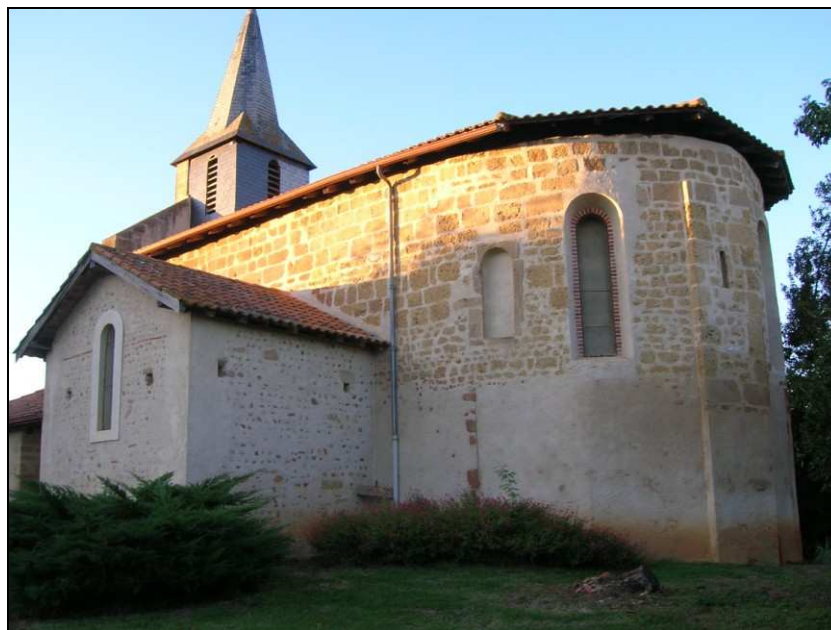
Fig. 51. - Photographie de l'église paroissiale de Manas (commune de Manas-Bastanous) avec abside à contreforts plats percés (XI e siècle).
