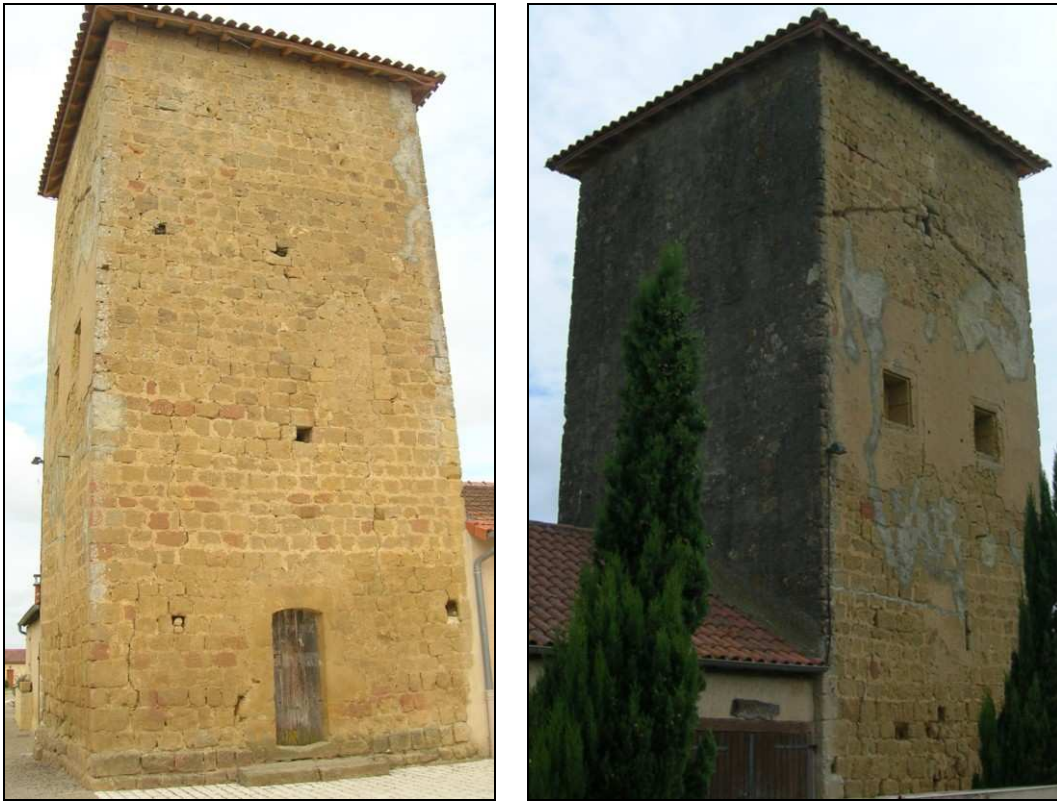
Fig. 64. - Photographies de la façade orientale de la tour de Miramont-d'Astarac avec porte rebouchée au premier étage (à gauche) et de la façade méridionale présentant divers aménagement d'un habitat attendant (à droite).
