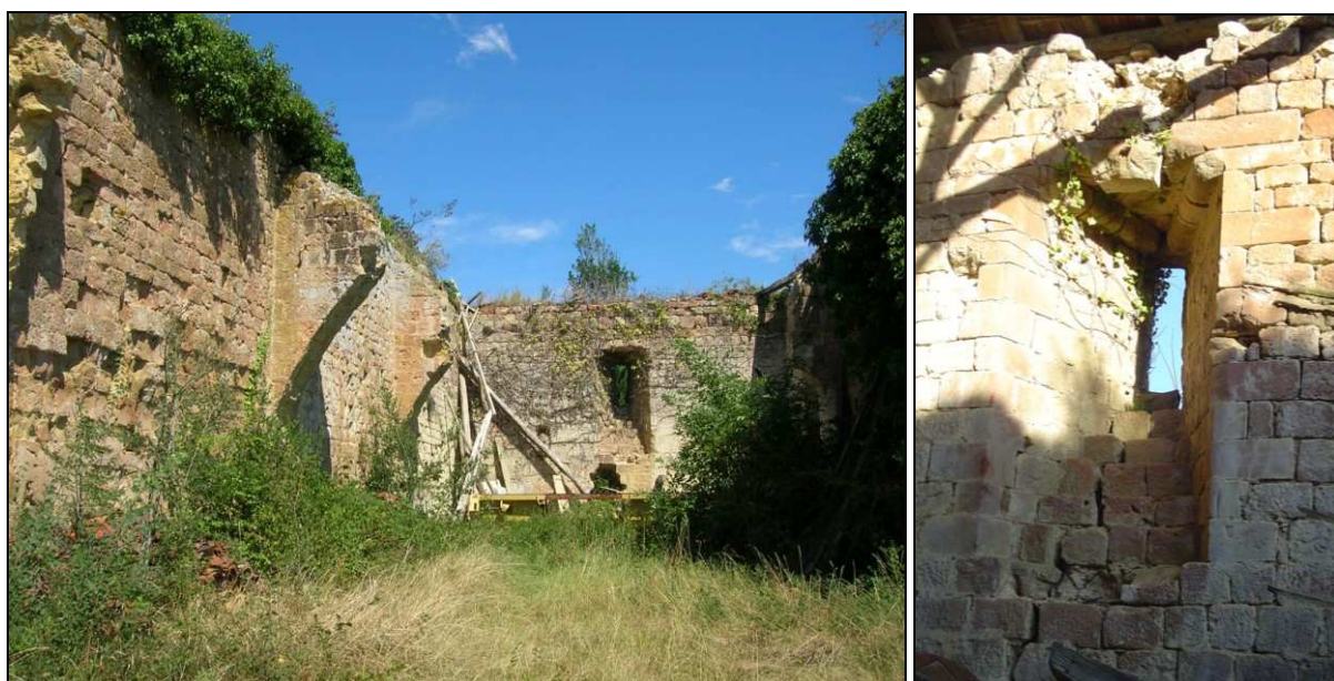
Fig. 71. - Photographies de l'espace intérieur de la Salasse (commune de Barran), vue sud et d'un jour ouvert sur la façade orientale.
