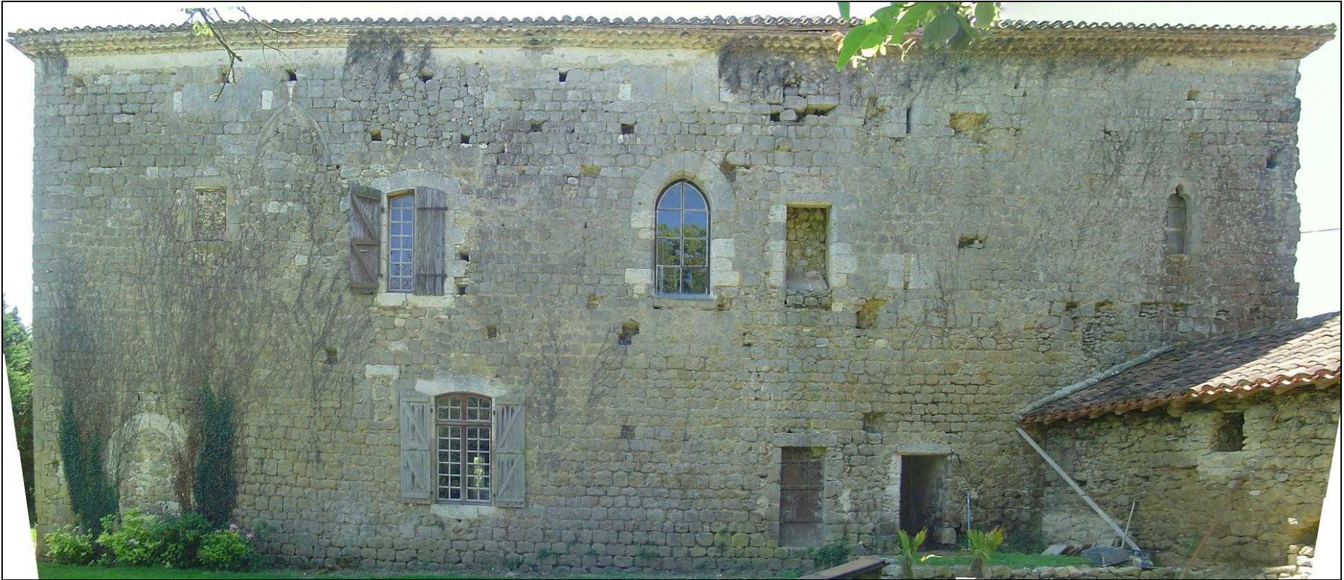
Fig. 80. - Photographie redressée de la façade septentrionale de la salle à tour intégrée de Pépieux (commune de Castelnaud-Barbarens). L'escalier à vis de la tour, souligné par la présence de deux jours étroits au premier et deuxième étage, marque la séparation entre la tour (à droite) et la salle (à gauche).
