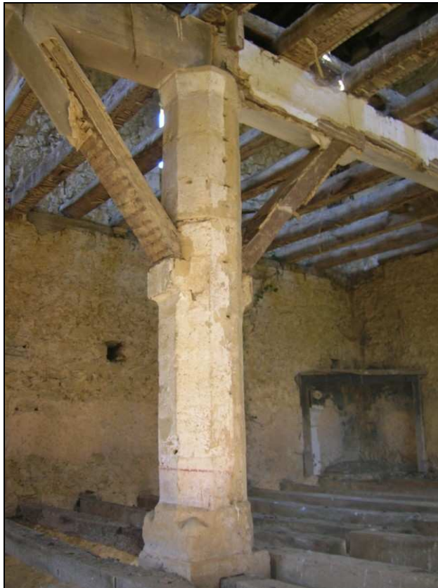
Fig. 69. - Photographie du pilier central de la salle du Capitou (commune de Barran) soutenant la poutre maîtresse du plancher du deuxième étage à l'aide d'aiseliers.
