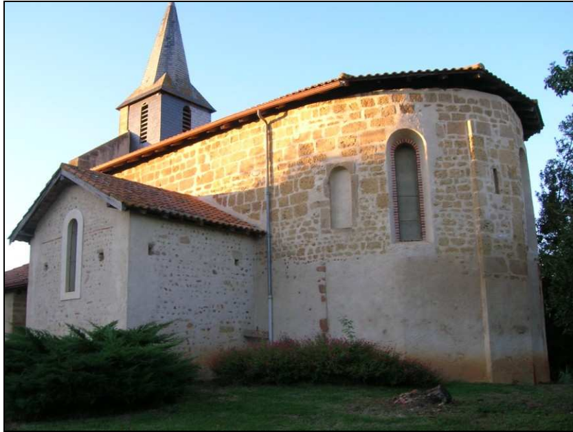
Fig. 51. - Photographie de l'église paroissiale de Manas (commune de Manas-Bastanous) avec abside à contreforts plats percés (XI e siècle).
