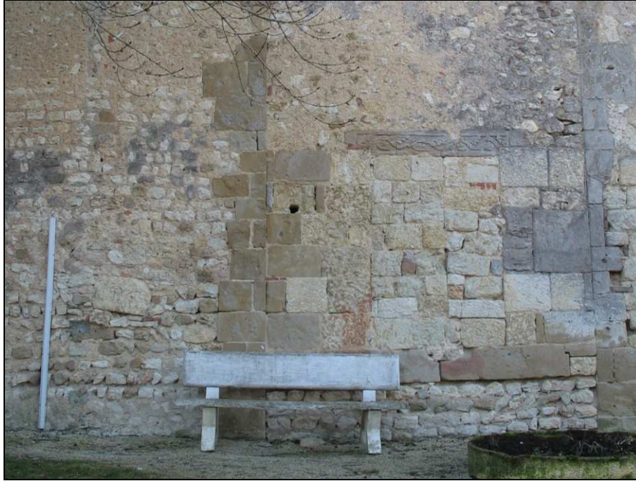
Fig. 25. - Détail du mur nord de la nef de l'église Saint-Michel de Pessan avec élément lapidaire en remploi (XI e siècle) utilisé comme linteau d'une entrée comblée.
