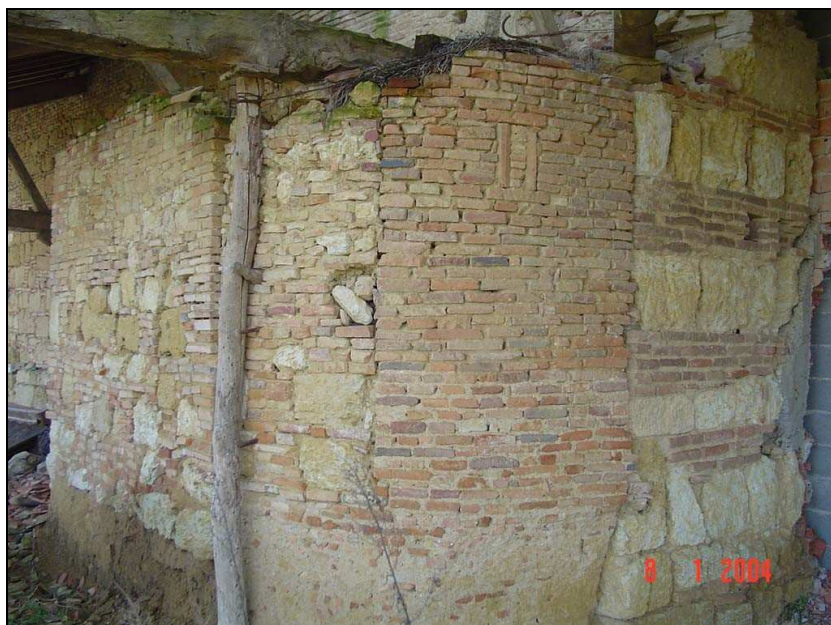
Fig. 94. - Vestiges de la tour d'angle nord-est du château de Montégut-Savès de construction mixte (brique-moellons calcaires).
