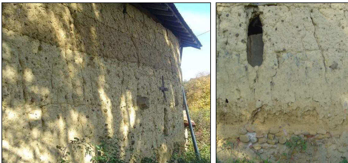
Fig. 88. - Photographie du mur en bauge de la demeure de Larbonne (commune de Haget) et détail du mur montrant l'élévation du mur de terre au-dessus d'un soubassement de pierre.
