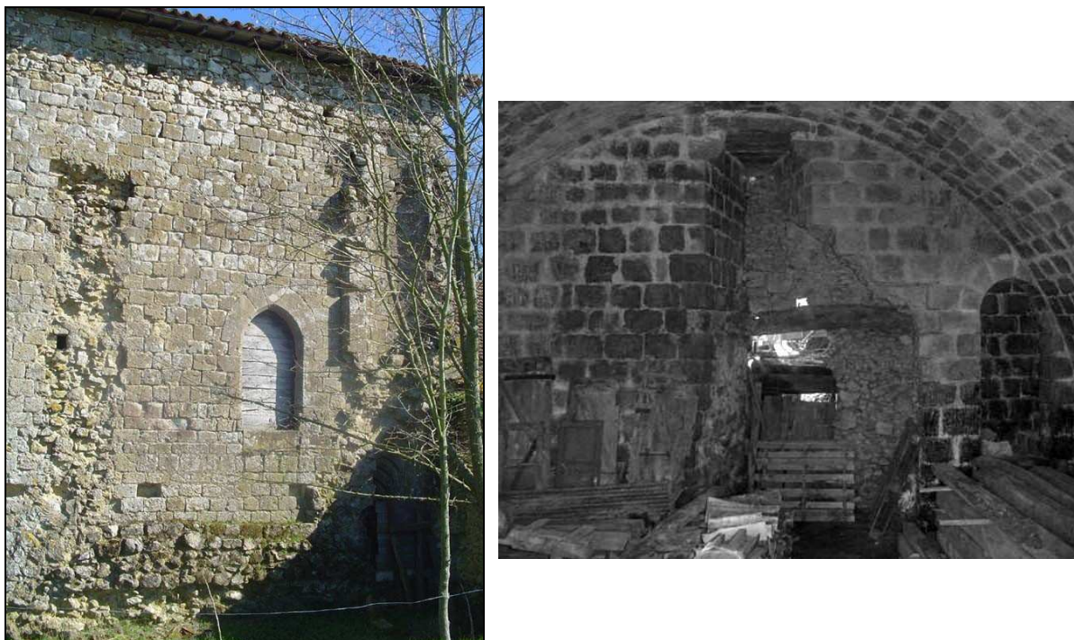
Fig. 62. - Photographies de la façade occidentale avec porte et arrachements de la tour (à droite) et de la pièce souterraine avec le jour comblé au centre et la porte de l’escalier (à gauche).
