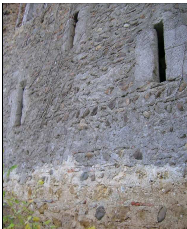
Fig. 96. - Détail de l'appareil employé et des jours du château de Montaut-d'Astarac (XIV e siècle).
