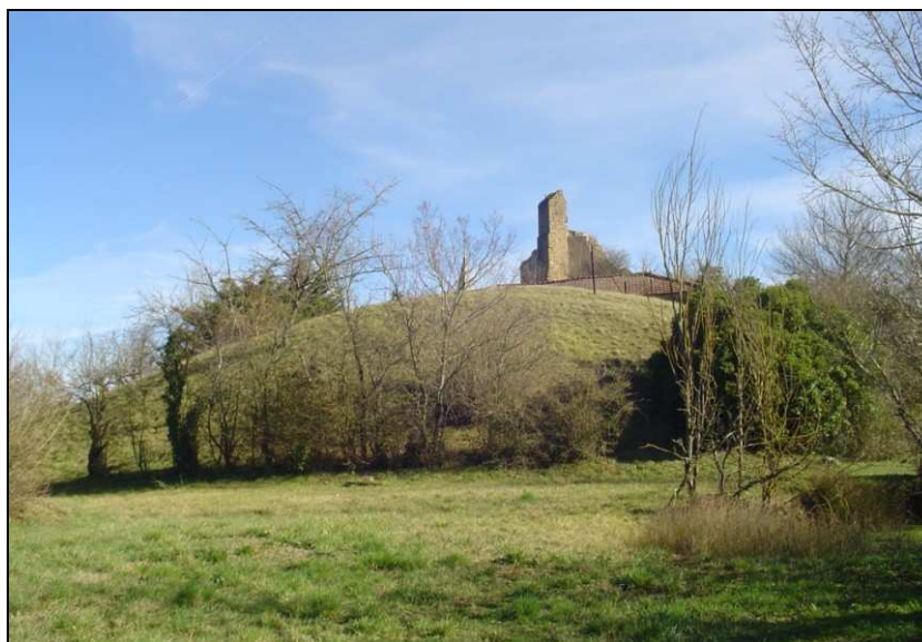
Fig. 42. - Photographie de la motte n° 2 de Durban, vue ouest. Au second plan, contrefort d'angle du logis du château comtal (XIV e siècle).
