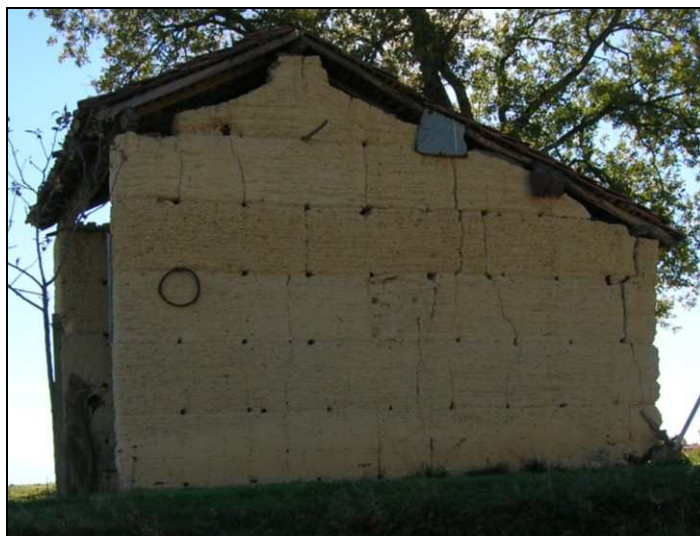
Fig. 87. - Grange employant la technique du pisé avec empreintes de clés (commune de Sadournin, Hautes-Pyrénées).
