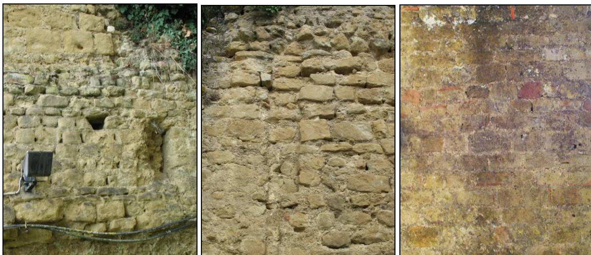
Fig. 29. - Photographies de comparaison des parements de la forteresse de Durban : courtine orientale avec trou de boulin et trou d'évacuation rebouché (à gauche), tour à contreforts (au centre) et logis quadrangulaire (à droite).
