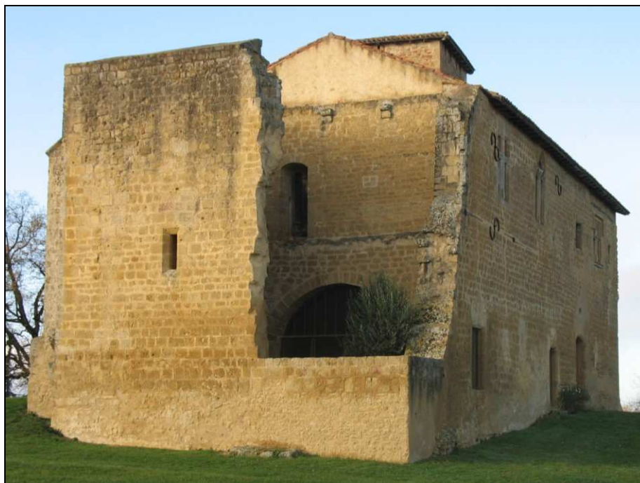
Fig. 72. - Photographie de la partie méridionale du château de Garrané (commune de Seissan).
