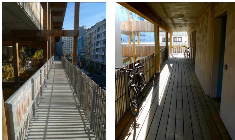
Photo 9 : Les deux types de sol de la passerelle : le béton brut sur le bâtiment B (à gauche) et les lattes en bois sur le bâtiment A (à droite)
