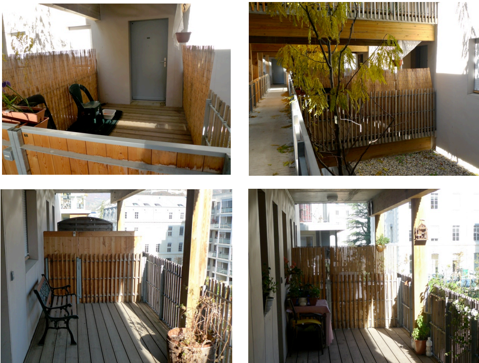
Photo 6 : Types de protections visuelles mises en place sur les terrasses 1
