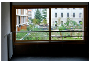
Baie coulissante du séjour (Bât B)
