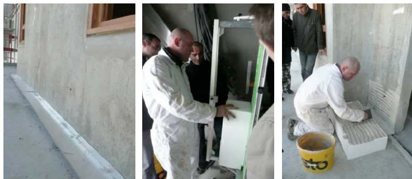
Photo 2 : Démonstration sur chantier de la mise en œuvre de l'isolation par l'extérieur. De gauche à droite : pose des rails de fixation, découpage au fil chauffant, encollage au mur 2
