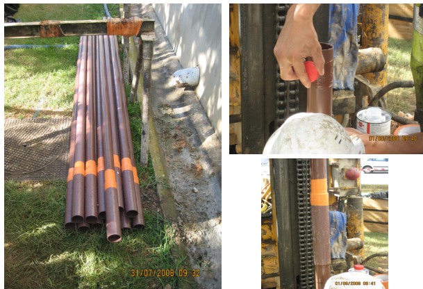
Figure 5.3 Mise en place des inclinomètres
