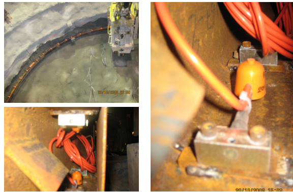
Figure 5.8 Pose du cintre instrumenté et jauges extensométriques
