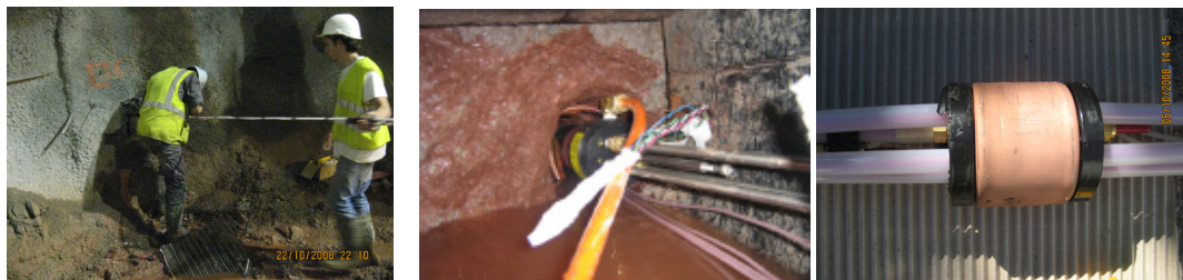
Figure 5.7 Extensomètres radiaux
