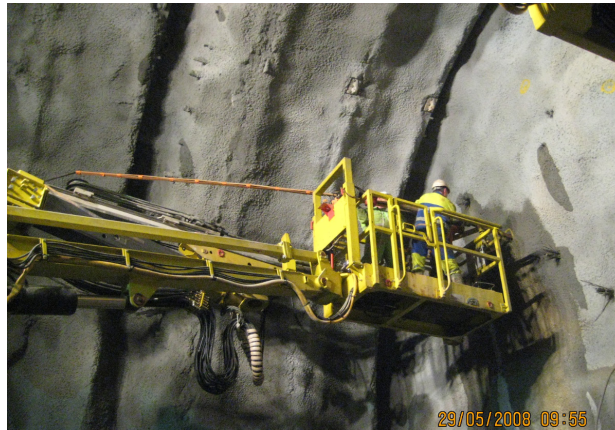
Figure 3.9 Enfilage d'un boulon en fibre de verre
