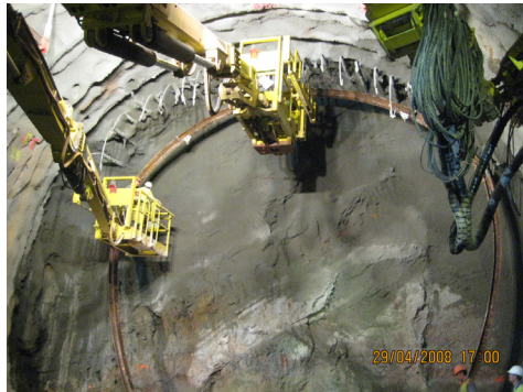
Figure 3.11 Pose et réglage du cintre
