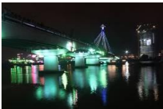
Pont du fleuve Hàn.
