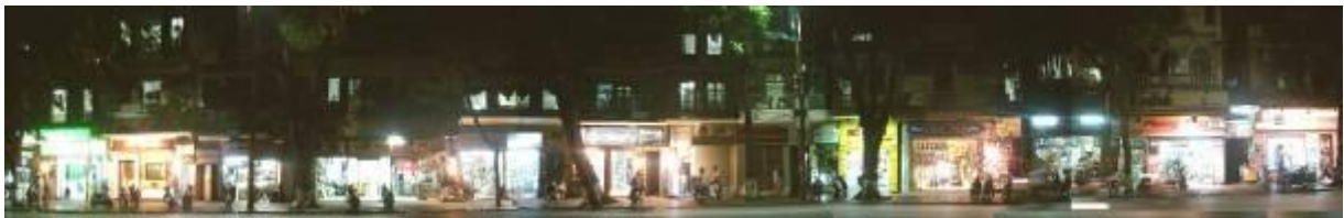
Figure 45 : Eclairage des maisons-tubes - continuation des boutiques
