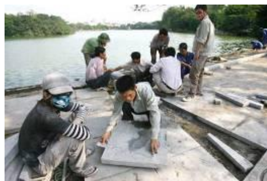
Le remplacement en pierres de taille de grand format
