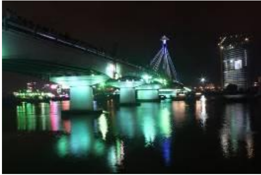
Pont du fleuve Hàn.
