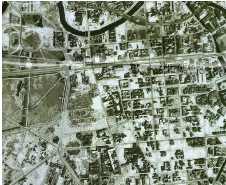
Figure 34 – Photographie aérienne du centre de Berlin en 1953
