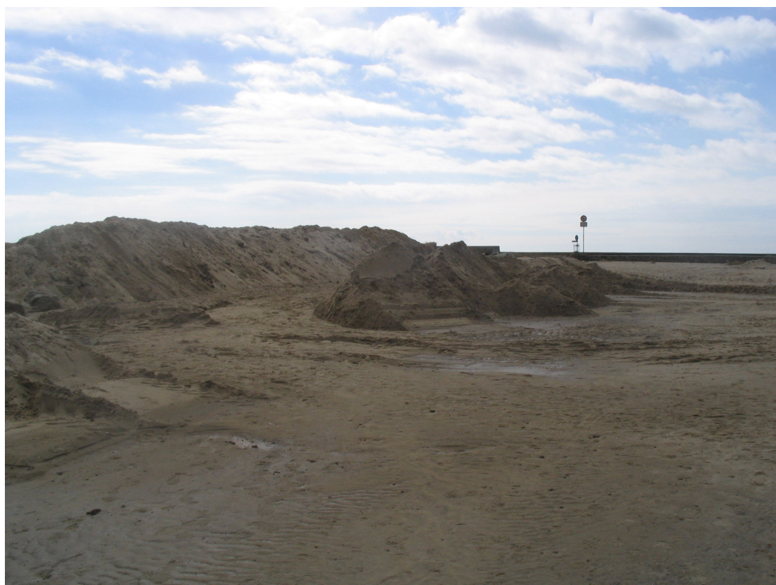
Photo A.2: Destruction du parking situé à l'arrière du mur de défense contre la mer à Gâvres lors de la tempête du 10 Mars 2008. Photographie prise le 15 Mars 2008.
