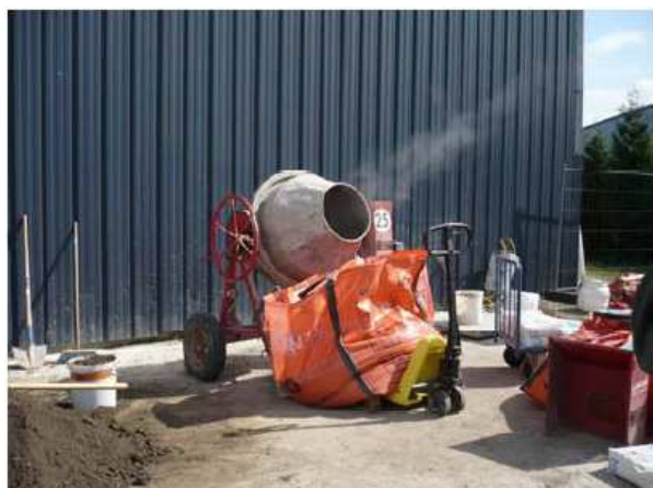
Figure II-1 : Photo prise lors de la mise en œuvre de la chaux dans le sédiment
