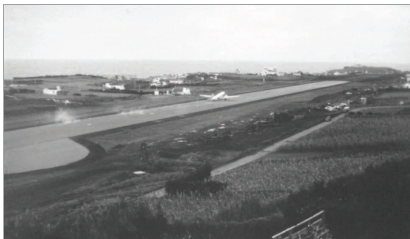
Figure 45 Aéroport de l'île de Flores après la construction de la piste, les débuts de l'abraço aereo - embrassement aérien - avec les autres îles et la France (ligne Flores-Biscarosse) – Collection photographique de Roberto Fraga (Santa Cruz das Flores)
