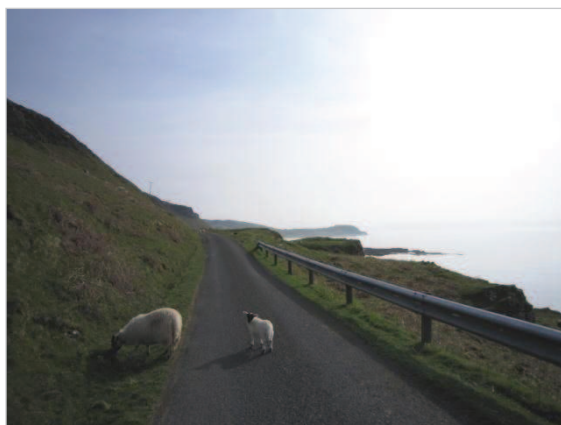
Figure 72 De rares moutons errent sur une route récemment rénovée mais bien peu empruntée (Ouest de Mull, Hébrides)
